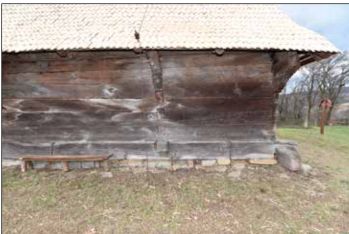
■ Photo 30. Calna, the northern elevation, where the joining of the wall between the pronaos and the naos can be seen © Ionel-Virgil POP ■ 30. kép: Kálna, az északi homlokzaton látható az előcsarnok és hajó közti fal © POP Ionel-Virgil
