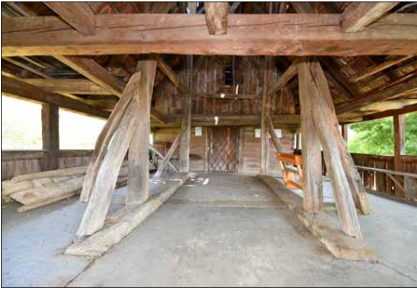
■ Photo 29. Băgău (Alba County), the bracing of the tower no longer introduces any stretch in the base on which it rests © Ionel-Virgil POP ■ 29. kép: Magyarbagó (Fehér megye), a torony merevítése már nem nyújtja meg a talpgerendát, amelyre terhel © POP Ionel-Virgil
