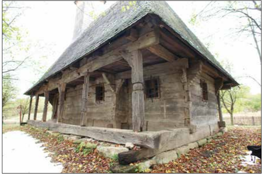
■ Photo 13. Calna, the two wall plates intersect so that the church is under a single roof © Ionel-Virgil POP ■ 13. kép: Kálna, a két ereszgerenda úgy metszi egymást, hogy a templom egy egységes tető alá kerül © POP Ionel-Virgil
