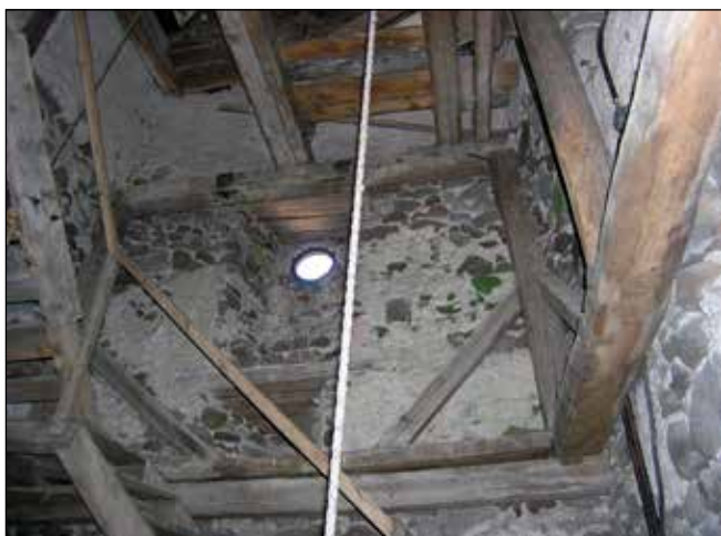
■ Foto 5. Goluri medievale înzidite și structuri din lemn în turnul din Sântimbru, 2020 © Boglárka TÓTH
