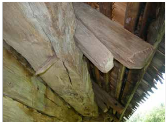
■ Photo 31. Calna, detail of fastening the common rafters to the wall plate with wooden nails © Ionel-Virgil POP ■ 31. kép: Kálna, a szarufák faszegek rögzítése az ereszgerendához, részlet © POP Ionel-Virgil
