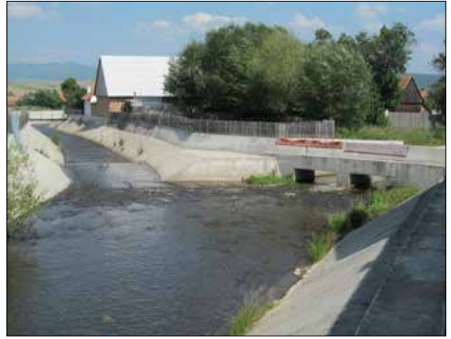
■ Foto 14. Albie betonată, Mădăraș/Csíkmadaras (HR), 2015 © Miklós KÖLLŐ
