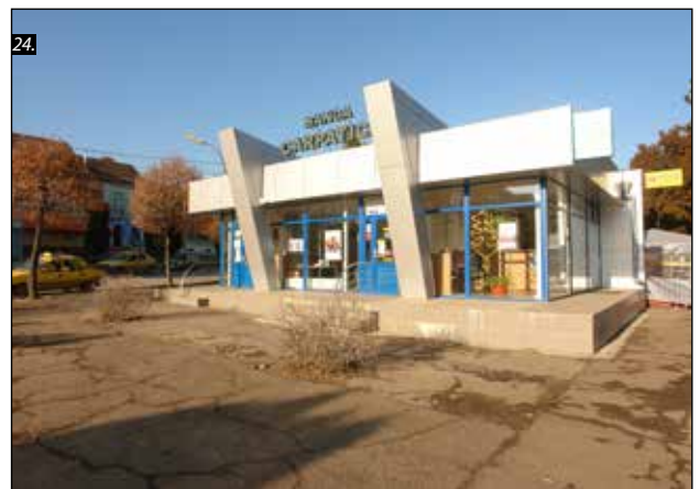
■ Foto 24. Reghin, piața s-a transformat în parc, iar în parc s-a amplasat o bancă privată. Mai multe legi au fost încălcate: s-a concesionat domeniul public către un investitor privat fără a exista un interes public major și s-a eliminat spațiul verde pentru o funcțiune neadmisă ca excepție © Virgil POP
