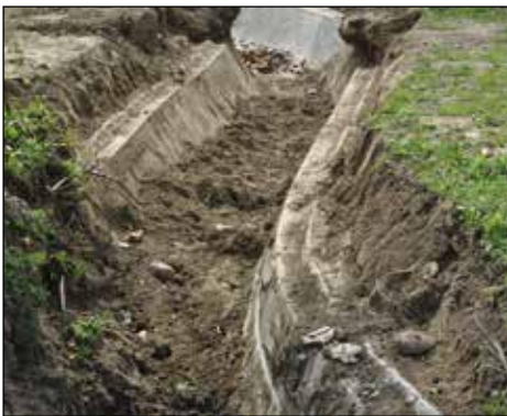
■ Foto 8. Acțiuni de curățare a canalelor de apă, 2014 © arh. Ioana TUDORA
