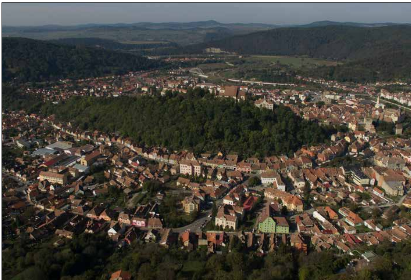
■ Foto 2. Fotografie aeriană Dealul Cetății ■ Photo 2. Aerial photograph of Cetății Hill
