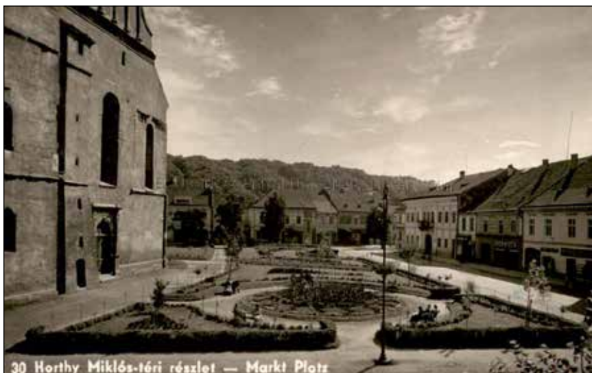
■ Foto 11. Ilustrată de pe la 1940, înfățișând Piața Centrală în dreptul frontului său sud-vestic. Observăm amenajările cu caracter ornamental din dreptul fațadei vestice a bisericii evanghelice lăsând, totuși, ca o alee mai largă de-a lungul fațadei, o zonă de parvii. Din repertoriul elementelor de amenajare fac parte elemente caracteristice perioadei: rondoul cu modele plantate variate, garduri vii de mică înălțime, locuri de ședere © Biblioteca Centrală Universitară „Lucian Blaga” ■ Photo 11. Postcard from around 1940, depicting the Central Square next to its south-western front. We notice the ornamental arrangements near the western elevation of the Lutheran Church, leaving space, however, for a parvis as a wider alley along the elevation. The repertoire of landscaping elements includes elements characteristic of the period: the round lawn with various planted patterns, low hedges, seating © “Lucian Blaga” Central University Library
