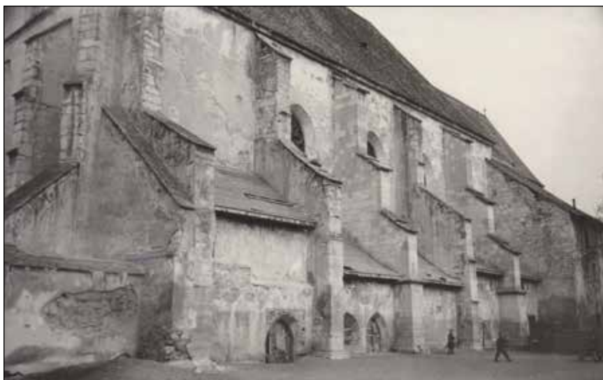
■ Foto 6. Fațada de sud a Bisericii Reformate de pe Strada Kogălniceanu din Cluj-Napoca, 1953, foto Ștefan BUTAK (INP, Fototeca DMI, nr. inv. 117, nr. 10)
