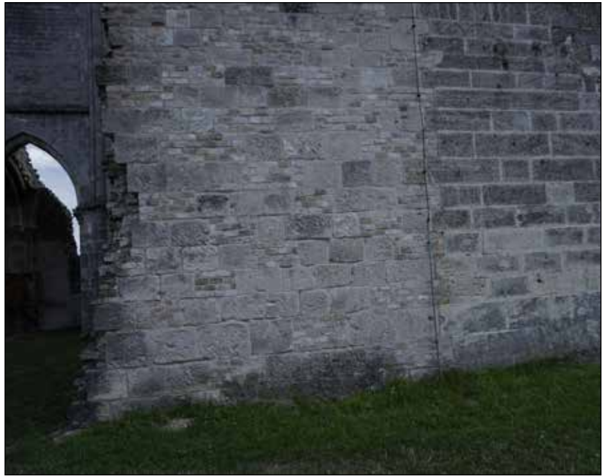
■ 12. kép: Kváderburkolat, téglából kifalazva, a templom északi oldalán © MEZŐS Tamás
