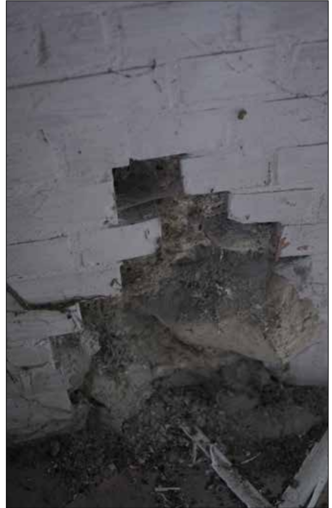
■ 7. kép: Eredeti falcsont a lépcsőtornyban © MEZŐS Tamás ■ Photo 7. Original wall fragment in the stair tower © Tamás MEZŐS
