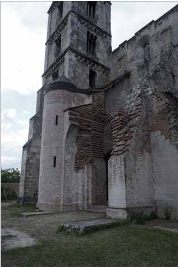
■ 8. kép: A déli kapu részleges rekonstrukciója © MEZŐS Tamás ■ Photo 8. Partial reconstruction of the southern portal © Tamás MEZŐS
