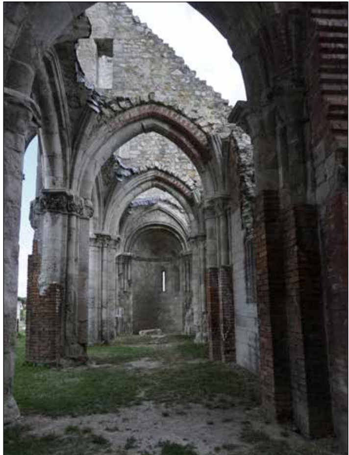
■ 9. kép: A déli mellékhajó hevedereinek képe dél felől © MEZŐS Tamás ■ Photo 9. View of the southern aisle's transverse arches © Tamás MEZŐS
