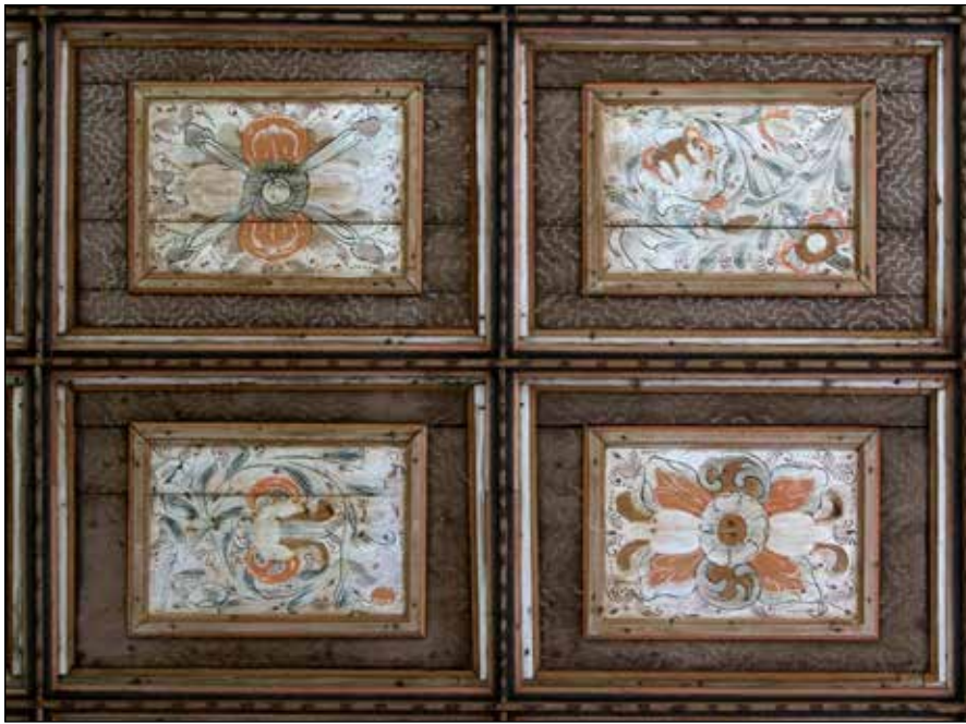
■ Photo 1. Wooden coffered ceiling detail, Calvinist Church in Mugeni © Utilitas ■ Foto 1. Detaliu tavan casetat din lemn, biserica reformată din Mugeni © Utilitas ■ 1. kép: Kazettás mennyezet részlet, bögyözi református templom © Utilitas
