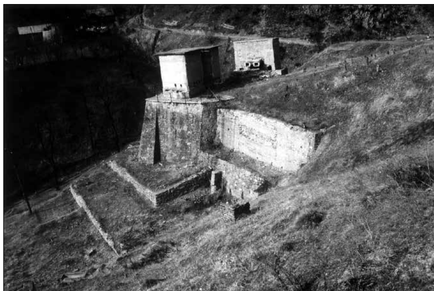
■ Foto 7. Urmele camerelor de detență ale uzinei de mercur din Valea Dosului (com. Izvorul Ampoiului) © Volker WOLLMANN, 2004
