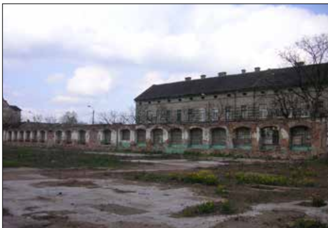
■ Foto. 3. Demolarea fostei Fabrici de Lanțuri © Liliana ROȘIU ■ Photo 3. The demolition of the former Chain Factory © Liliana ROȘIU
