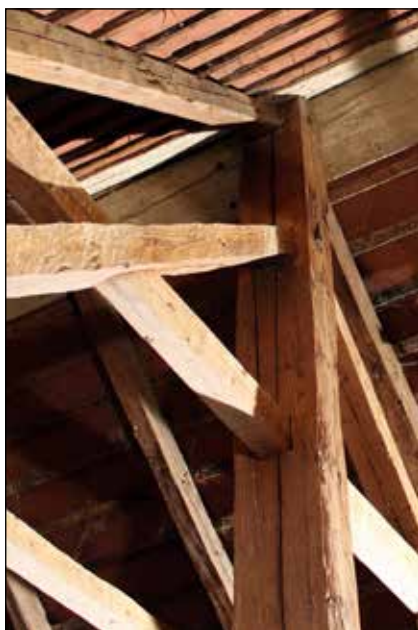
■ Foto 2. Wooden roof structure detail © Utilitas ■ Photo 2. Detaliu șarpantă de lemn © Utilitas ■ 2. kép: Fa fedélszerkezet részlet © Utilitas
