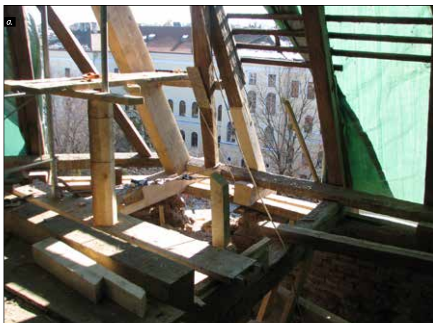
■ Foto 2a. I – proptiri și preluarea împingerii pe parcursul execuției ■ Photo 2a. I – props and the transfer of thrust during implementation
