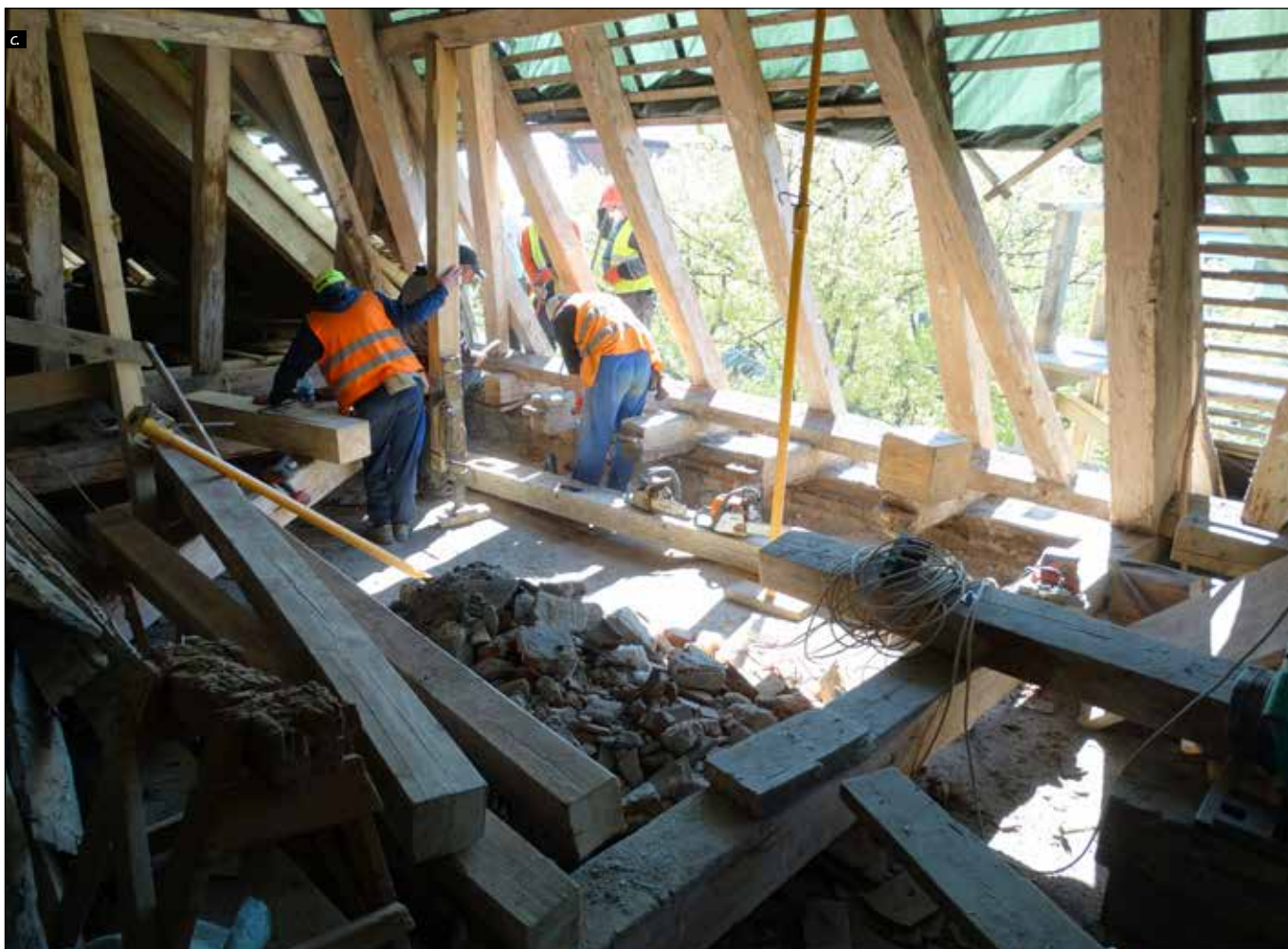
■ Foto 2c. IV – intervențiile la șarpantă necesită muncă de echipă ■ Photo 2c. IV – roof structure interventions require team work
