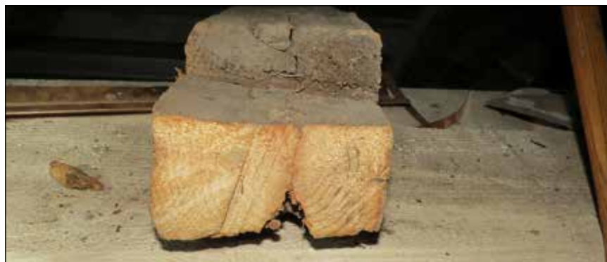
■ Foto 3. Lemn rășinos introdus la intervenții ulterioare, inele anuale cu densitate redusă © Livia BUCȘA
