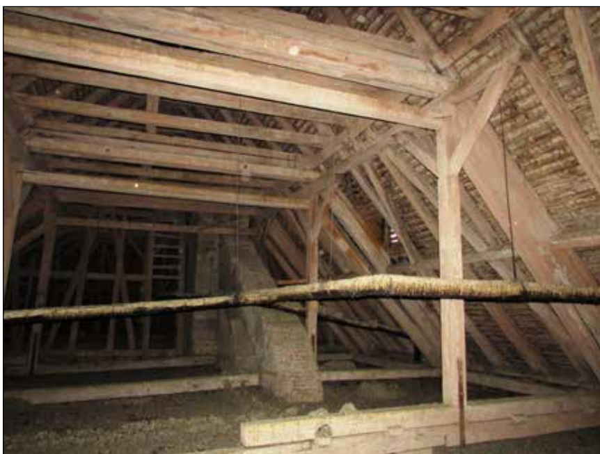
■ Foto 1d. Șarpanta (IV) Palatului Episcopal Romano-catolic Oradea, jud. Bihor, înainte de intervenție ■ Photo 1d. Roof structure (IV) of the Roman-Catholic Bishopric Palace in Oradea, Bihor Co., before the intervention
