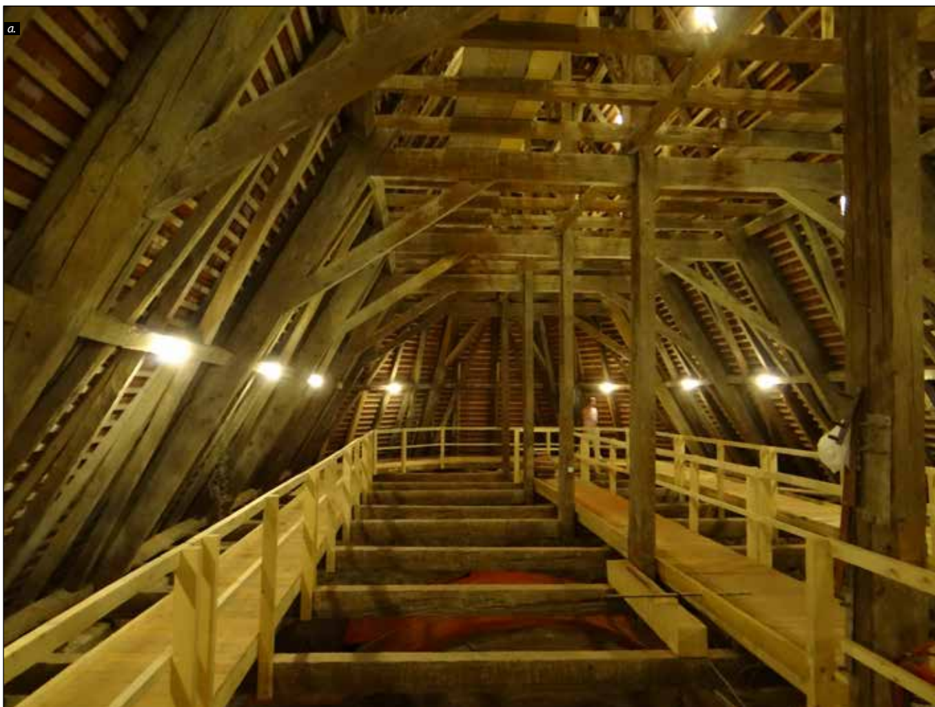
■ Foto 3a. I – șarpanta corului Bisericii Reformate de pe strada Kogălniceanu, din Cluj-Napoca, după intervenți ■ Photo 3a. I – the roof structure over the choir of the Calvinist Church in Kogălniceanu Street, Cluj-Napoca, after the interventions
