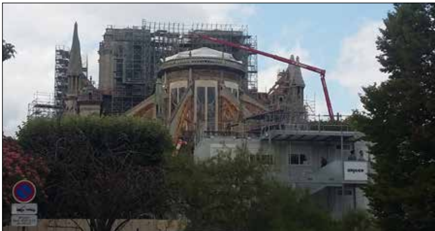
■ 5 kép: Védőtető- és fóliaépítés, a támívek és a mérnöves ablakok stabilizálása 2019. július végén © GÉCS Attila
