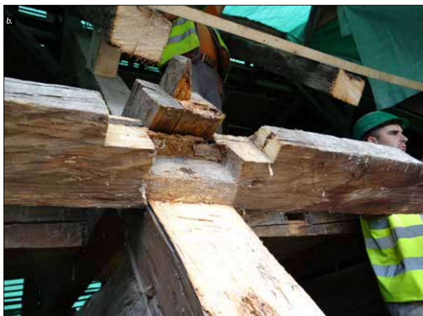
■ Foto 2b. I – nod pregătit pentru introducerea zonelor de elemente care necesită înlocuire ■ Photo 2b. I – joint prepared for the introduction of elements to be replaced
