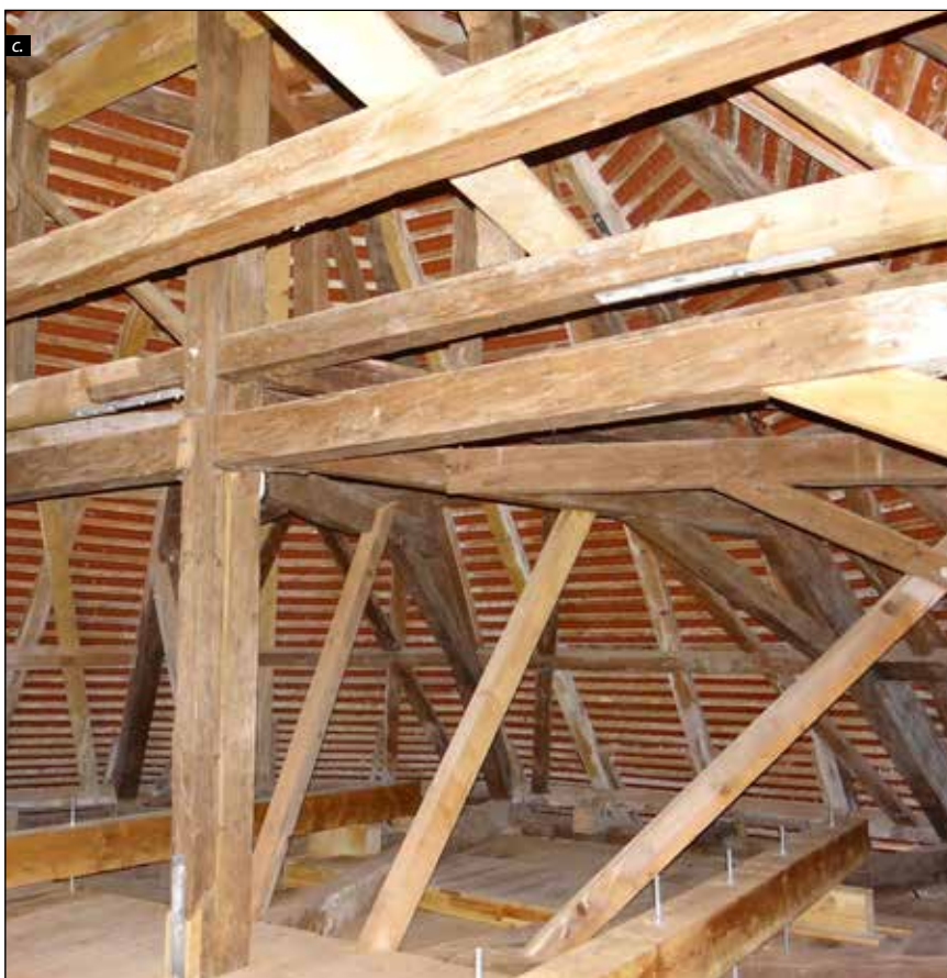
■ Foto 3c. III – șarpanta corului Bisericii Unitariene din Bădeni, după restaurare ■ Photo 3c. III – the roof structure over the choir of the Unitarian Church in Bădeni, after conservation
