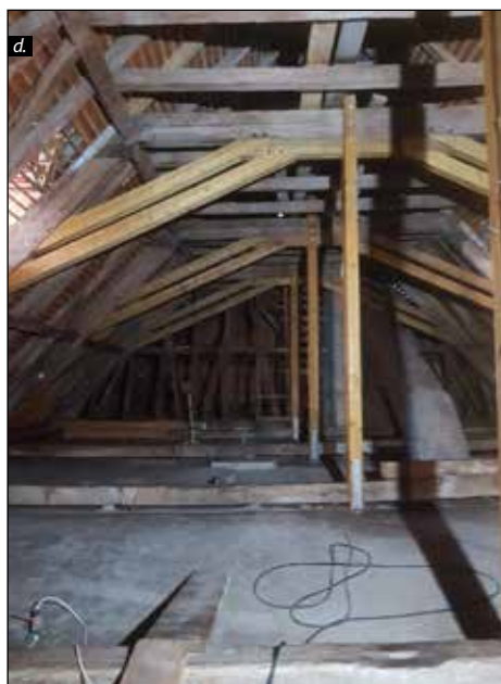
■ Foto 3d. IV – vedere latura sud a șarpantei reabilitate din Palatul Episcopal Romano-catolic Oradea, după restaurare ■ Photo 3d. IV – southern side of the rehabilitated roof structure over the Roman Catholic Bishopric Palace in Oradea, after conservation
