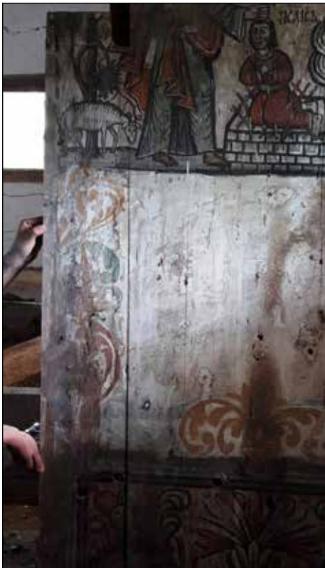
■ Photo 2. Pictura descoperită pe extradrosul scândurilor altarului, datând din 1698, descoperită în timpul șantierului de restaurare în mai 2019 © Pr. Ionel COTOCEA
