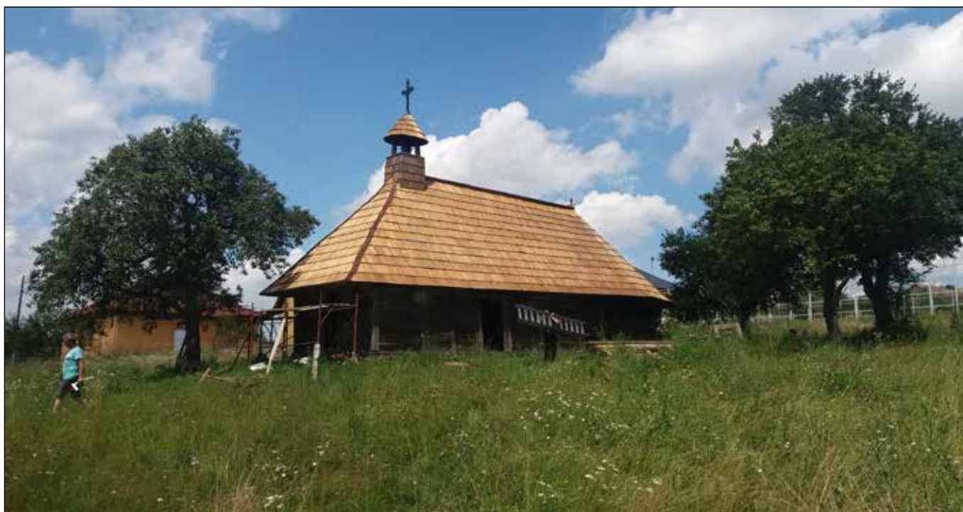
■ Foto 7. Biserica de lemn din Dragomirești după încheierea șantierului © Diana BELCI ■ Photo 7. The wooden church in Dragomirești after the intervention © Diana BELCI
