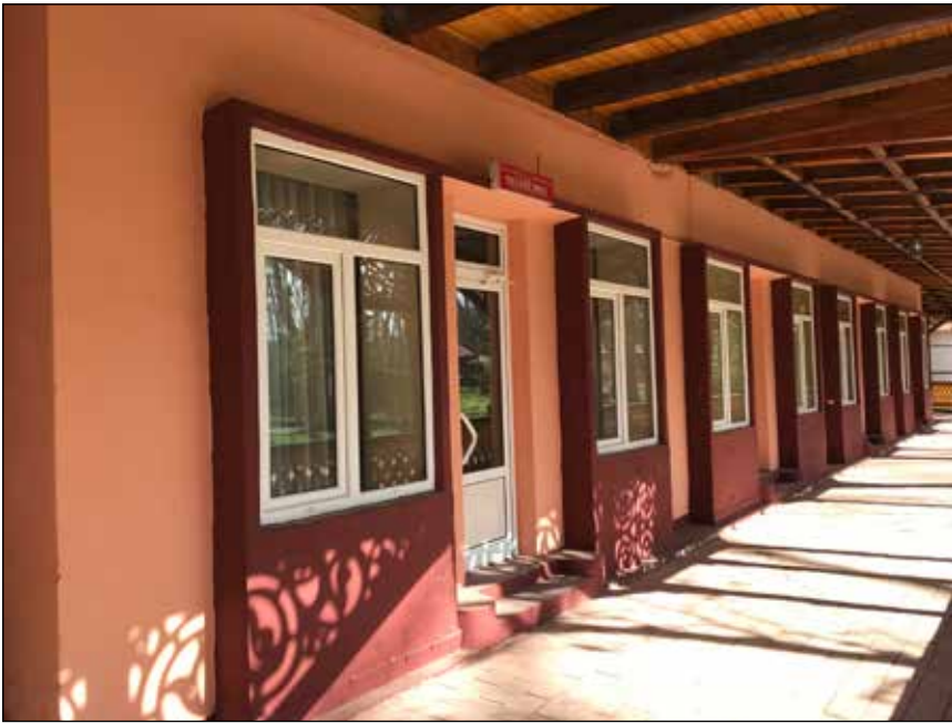
■ Foto 8. Suită de goluri modificate parter fațadă principală, sub copertina de lemn a colonadei © bondstudio 2018
