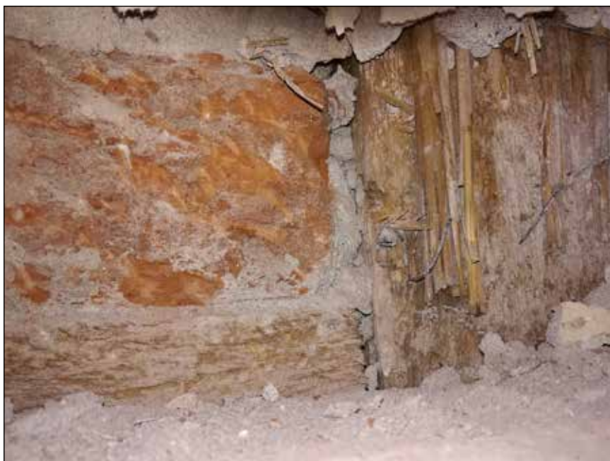
■ Foto 4. Detaliu perete cu structură de lemn și zidărie din cărămidă © bondstudio 2018 ■ Photo 4. Detail of a wall with timber structure and brick masonry © bondstudio 2018
