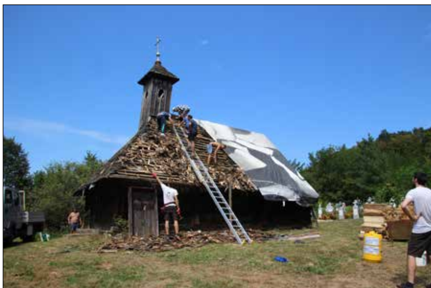
■ Foto 3. Biserica de lemn de la Jupânești în timpul șantierului © Diana BELCI ■ Photo 3. The wooden church in Jupânești during the intervention © Diana BELCI
