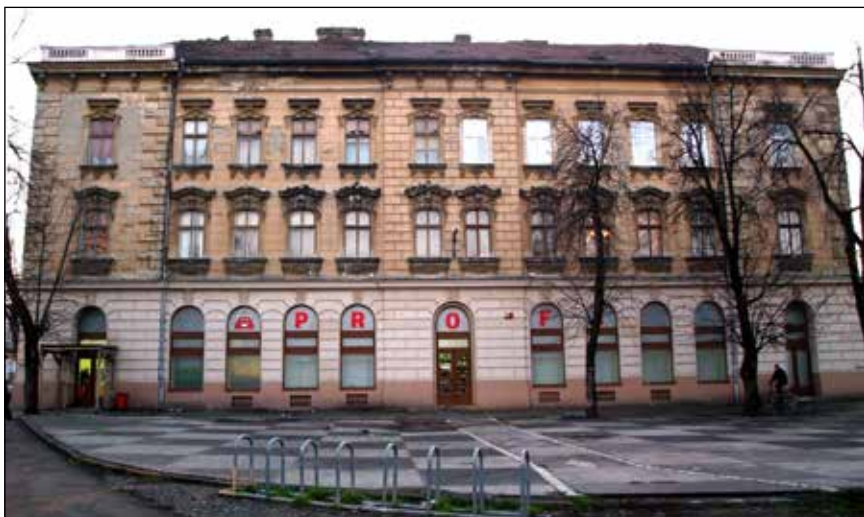
■ Foto 2. Starea clădirii la începerea proiectului © Brîndușa Raluca HAVASI
