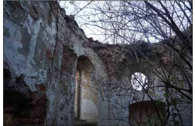
■ Foto 12. Poză interioară din capela barocă. Poza surprinde nașterea bolții baroce din altar. Imaginea este perturbată de vegetație, 2018 © Maria Alexandra SAS ■ Photo 12. Interior view of the Baroque chapel, with the Baroque vault's springers in the choir. The view is disturbed by the vegetation, 2018 © Maria Alexandra SAS
