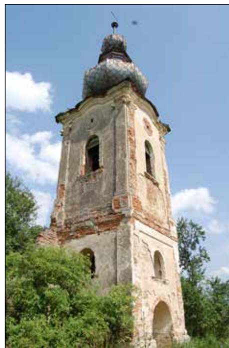
■ Foto 10. Capela barocă, imagine exterioară. Învelitoarea turlei este cea originală, de-a lungul timpului fațada a fost afectată de precipitații și de lipsa de întreținere, 2018 © Maria Alexandra SAS ■ Photo 10. The Baroque chapel, exterior view. The tower's roof covering is original, the elevation was affected over time by weathering and lack of maintenance, 2018 © Maria Alexandra SAS
