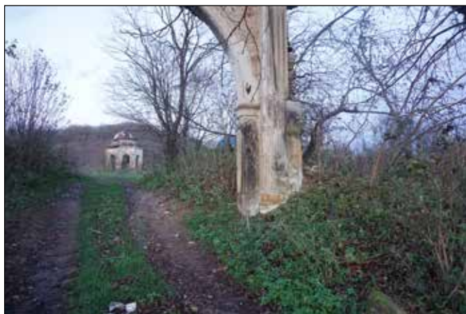
■ Foto 8. Poză cu degradări, în prin plan se află poarta barocă, în plan secund fântâna barocă, 2018 © Maria Alexandra SAS ■ Photo 8. Photograph presenting the degradations, with the Baroque gate in the foreground and the Baroque well in the background, 2018 © Maria Alexandra SAS
