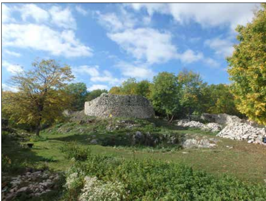
■ 5 kép: Az összefogás eredménye: rendezett várudvarok, falázáshoz összehordott kövek © KELEMEN Bálint Zoltán ■ Photo 5. The result of the cooperation: ordered baileys, stones gathered for masonry work © Bálint Zoltán KELEMEN
