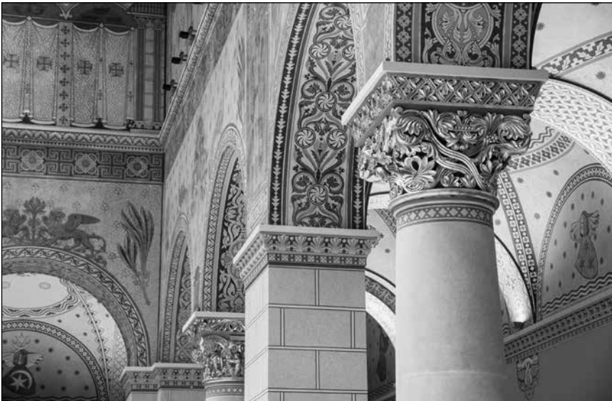
■ 7. kép: A Román Csarnok váltakozó támaszrendszere a beavatkozás után © AMENT Gellért ■ Photo 7. The alternate-support system of the Romanesque Hall after the intervention © Gellért AMENT
