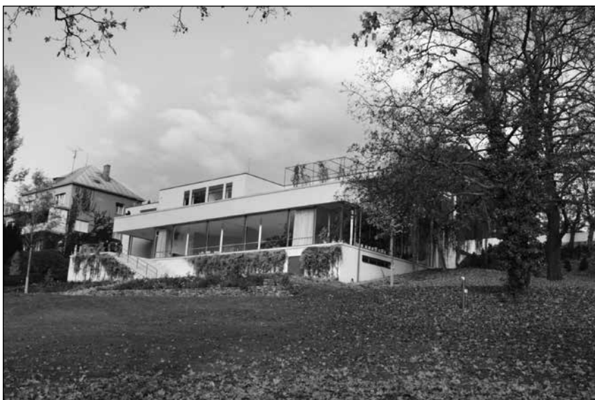
■ 7. kép: „Eredeti” formájára visszaállított műemlék: Brunn, Tugendhat-ház (MIES VAN DER ROHE, 1928) © VEÖREŐS András
