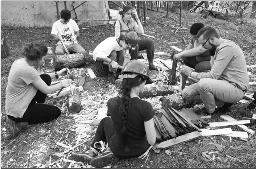
■ Photo 6. Volunteers working with the parish priest to prepare the material needed for a new roof covering at the timber church in Brusturi (Sălaj Co.), 2018 © Ileana BURNICHIOIU ■ Foto 6. Voluntari lucrând alături de preotul paroh pentru pregătirea materialului necesar unei noi învelitori la biserica de lemn din Brusturi (jud. Sălaj), 2018 © Ileana BURNICHIOIU ■ 6. kép: Önkéntesek és a helyi pap munka közben, hogy előkészítsék a somróújfalusi fatemplom (Szilágy megye) új tetőjéhez szükséges anyagot, 2018 © Ileana BURNICHIOIU
