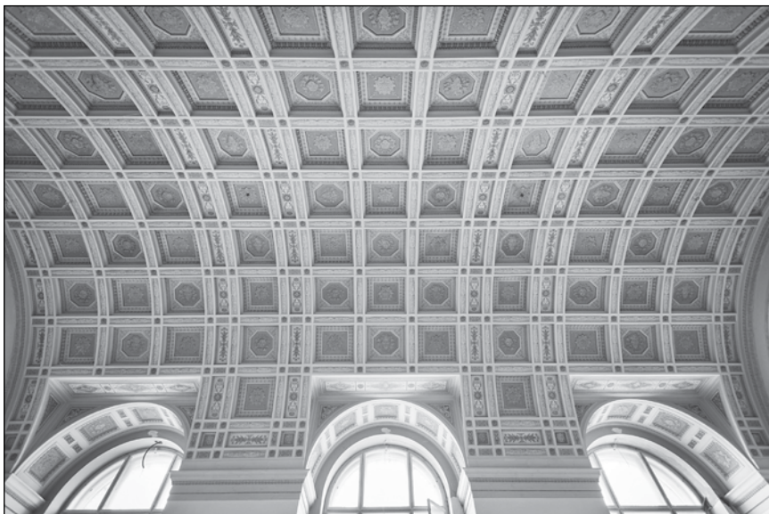
■ 10. kép: Kazettás boltozat a Szépművészeti Múzeumban © AMENT Gellért ■ Photo 10. Coffered vault in the Museum of Fine Arts © Gellért AMENT
