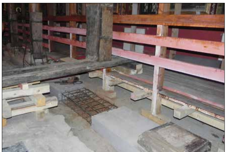
■ Foto 4. Biserica Sf. Ilie-Gorgani. Turnarea centurii din beton sub stâlpii din lemn ridicaiți ■ Photo 4. The Church of Saint Ilie-Gorgani. Casting the concrete belt under the raised timber pillars
