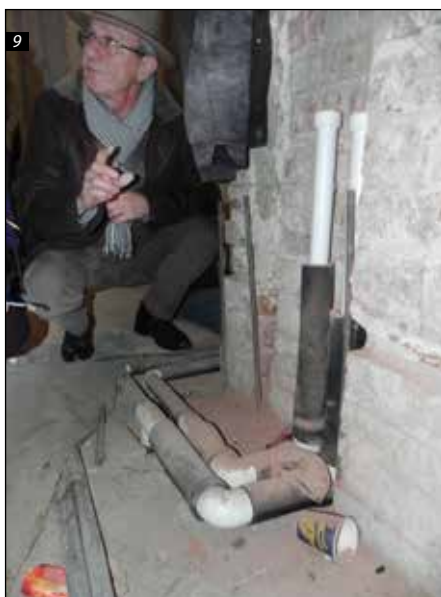
■ Foto 9. Observatorul Astronomic Amiral Vasile Urseanu. Pregătirea traseelor de instalații înainte de turnarea șapelor
