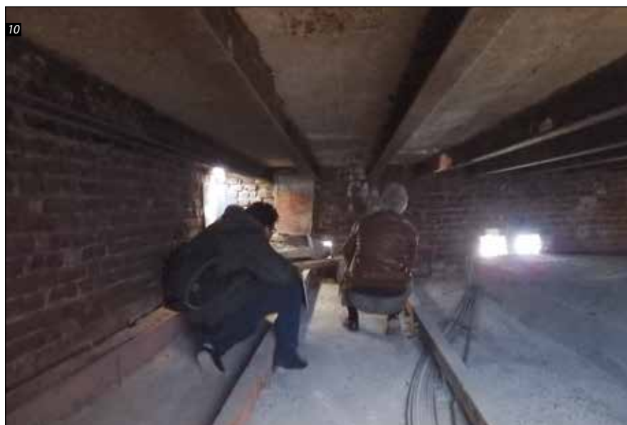
■ Foto 9. Observatorul Astronomic Amiral Vasile Urseanu. Pregătirea traseelor de instalații înainte de turnarea șapelor
