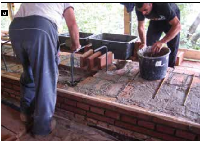
■ Foto 3a-b. Biserica Sf. Ilie-Gorgani. Realizarea centurii din beton armat la nivelul cornișei ■ Photo 3a-b. The Church of Saint Ilie-Gorgani. Implementation of the reinforced concrete cornice belt
