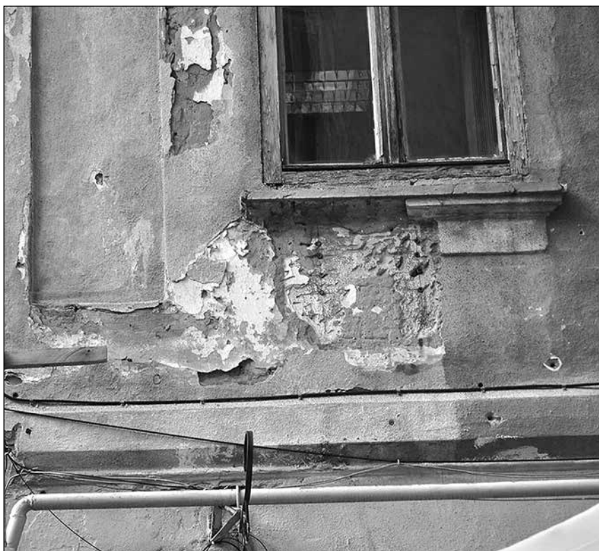
■ Foto 7. Amprenta profilului descoperit pe parapetul ferestrelor, sub tencuială (PESCAR, DRAȘCOVICI & ROȘIU 2017)
