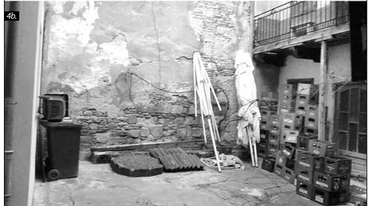
■ Foto 4. a. Urmele fundației Porții Forforosa. b. Calcan construit cu piatră din Poarta Forforosa (PESCAR, DRAȘCOVICI & ROȘIU 2017) © V. BUNOIU
