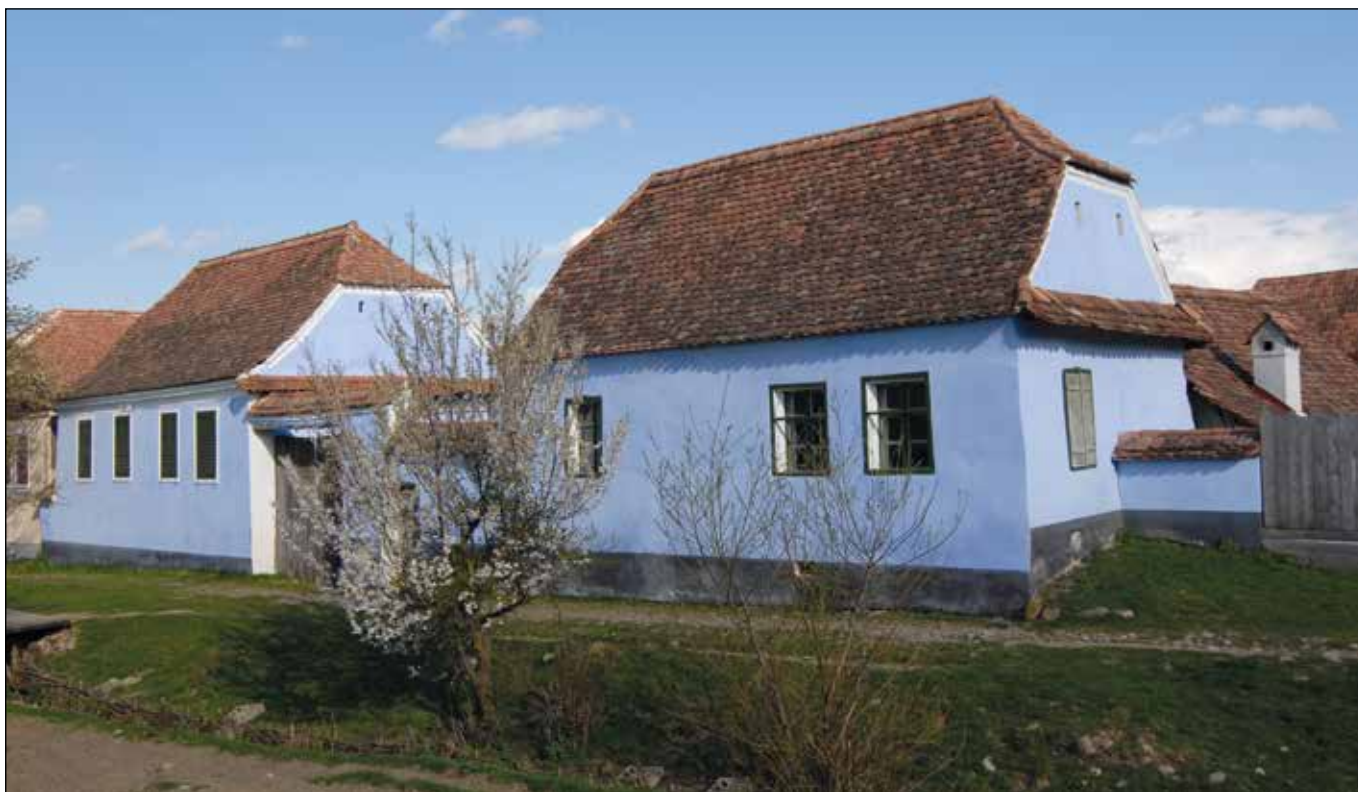
■ Foto 8. Viscri, nr. 163. Gospodăria după reabilitare, cu casa din dreapta reconstruită ■ Photo 8. House No. 163, Viscri. Household after conservation, with the house on the right reconstructed
