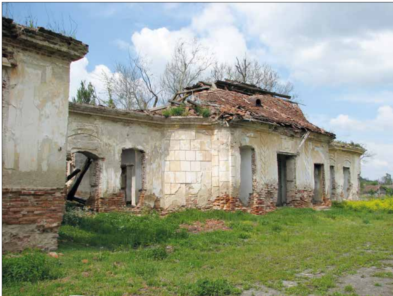
■ Foto 9. Partea estică a castelului (probabil o extindere de la sfârșitul secolului al XIX-lea sau începutul secolului al XX-lea), privită din fosta curte utilitară © Andreea MILEA, 2007
