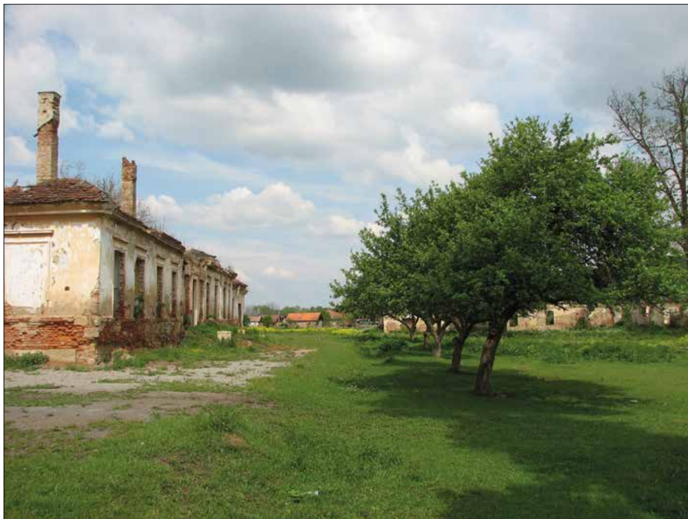
■ Foto 6. Latura sudică a castelului, orientată spre fosta curte utilitară conturată de clădirile anexe. În prezent, un aliniament de pomi fructiferi este condus în paralel cu fațada castelului © Andreea MILEA, 2007
