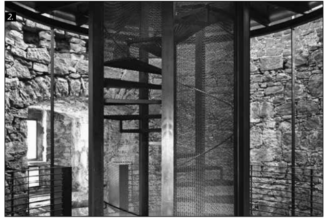
■ Fotos 1-3. Firmiano Castle (Italy). Conservation of the ruin image and (reversible) additions in a contemporary style, ensuring accessibility for visits. Architect Werner TSCHOLL, 2006, Source: http://divisare.com/projects/124961-werner-tscholl-alexa-rainer-castel-firmiano © Alexa RAINER ■ Foto 1-3. Castelul Firmiano (Italia). Conservarea imaginii ruinei și completări (reversibile) în registru contemporan, care asigură accesibilitatea pentru vizitare. Arhitect Werner TSCHOLL, 2006, Sursa: http://divisare.com/projects/124961-werner-tscholl-alexa-rainer-castel-firmiano © Alexa RAINER ■ 1-3. kép: Firmiano-kastély (Olaszország). A rom összképének megőrzése és a látogathatóságot biztosító (visszafordítható) pótlások kortárs megoldásokkal. Werner TSCHOLL építész, 2006, Forrás: http://divisare.com/projects/124961-werner-tscholl-alexa-rainer-castel-firmiano © Alexa RAINER
