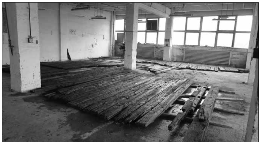
■ Foto 11. Sortarea materialului lemnos înainte de reconstrucție
