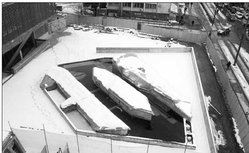
■ Foto 13. Sortarea materialului lemnos înainte de reconstrucție
