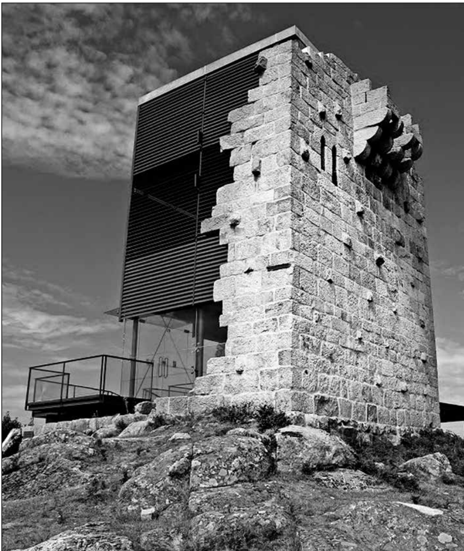
■ Foto 4. Torre de Vilharigues (Portugal). Conservation of the ruin image and (reversible) additions in a contemporary style, ensuring accessibility for visits. Architect Renato REBELO, 2013, Source: http://www.medievalhistories.com/matrera-castle-vilharigues-tower/ © João Paulo COUTINHO ■ Foto 4. Torre de Vilharigues (Portugalia). Conservarea imaginii ruinei și completări (reversibile) în registru contemporan, care asigură accesibilitatea pentru vizitare. Arhitect Renato REBELO, 2013, Sursa: http://www.medievalhistories.com/matrera-castle-vilharigues-tower/ © João Paulo COUTINHO ■ 4. kép: Vilharigues-torony (Portugália). A rom összképének megőrzése és a látogathatóságot biztosító (visszafordítható) pótlások jelenkori megoldásokkal. Renato REBELO építész, 2013, http://www.medievalhistories.com/matrera-castle-vilharigues-tower/ © João Paulo COUTINHO
