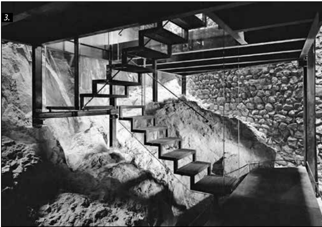
■ Fotos 1-3. Firmiano Castle (Italy). Conservation of the ruin image and (reversible) additions in a contemporary style, ensuring accessibility for visits. Architect Werner TSCHOLL, 2006, Source: http://divisare.com/projects/124961-werner-tscholl-alexa-rainer-castel-firmiano © Alexa RAINER ■ Foto 1-3. Castelul Firmiano (Italia). Conservarea imaginii ruinei și completări (reversibile) în registru contemporan, care asigură accesibilitatea pentru vizitare. Arhitect Werner TSCHOLL, 2006, Sursa: http://divisare.com/projects/124961-werner-tscholl-alexa-rainer-castel-firmiano © Alexa RAINER ■ 1-3. kép: Firmiano-kastély (Olaszország). A rom összképének megőrzése és a látogathatóságot biztosító (visszafordítható) pótlások kortárs megoldásokkal. Werner TSCHOLL építész, 2006, Forrás: http://divisare.com/projects/124961-werner-tscholl-alexa-rainer-castel-firmiano © Alexa RAINER
