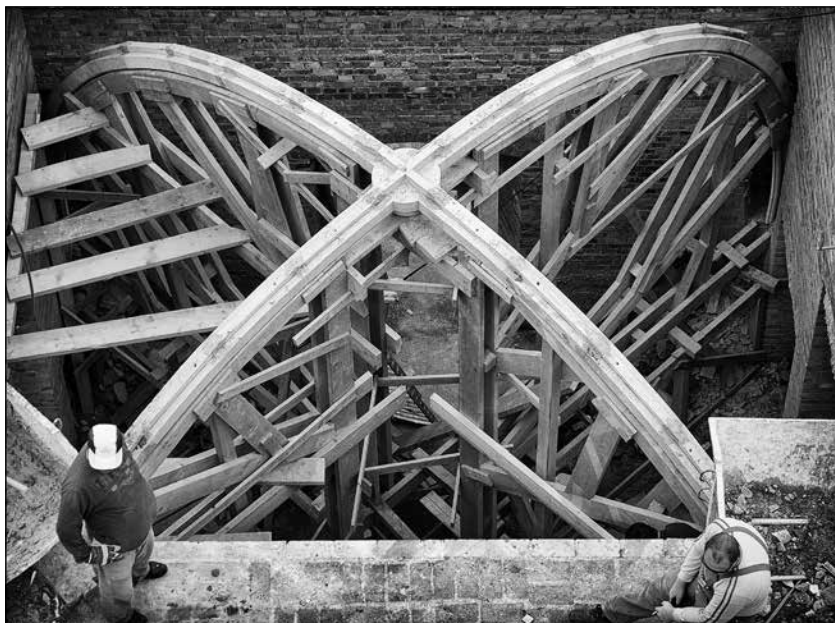
■ 7. kép: Bordás keresztboltozat építés közben ■ Photo 7. The ribs of a cross vault during construction
