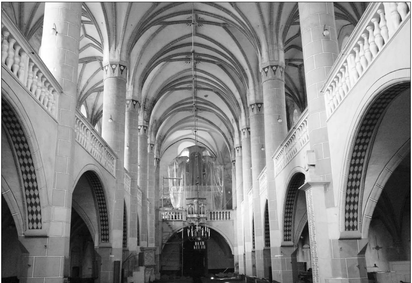
■ Foto 1. Nava bisericii – vedere spre orgă, în starea de dinaintea intervențiilor din 2013
