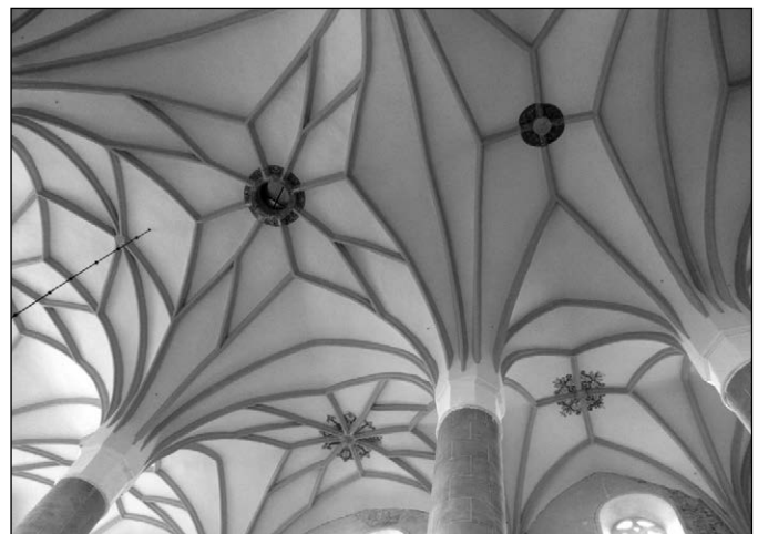
■ Foto 8. Planșeul acoperiș boltit în urma intervențiilor de consolidare-restaurare
