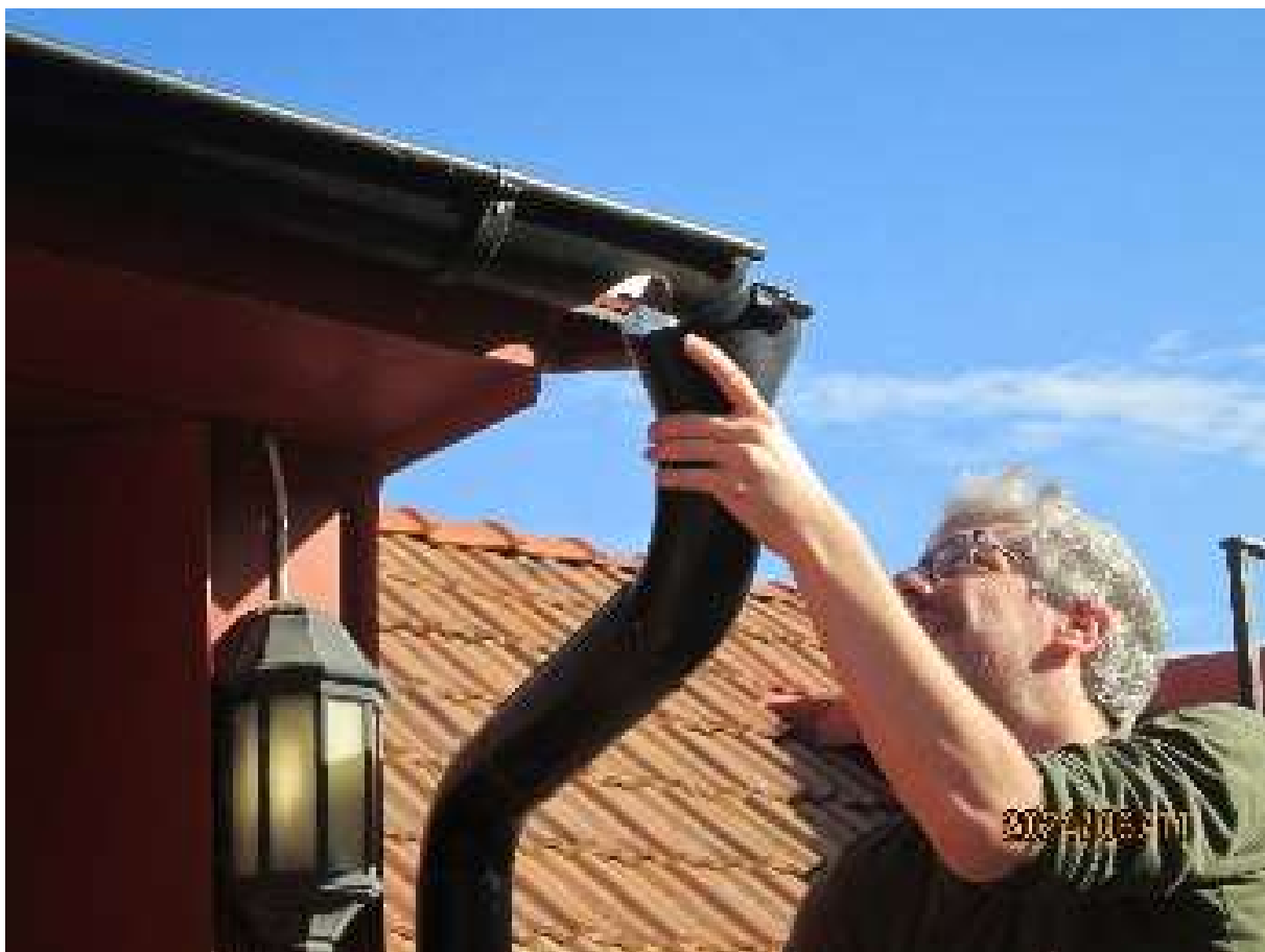
A műemlékes ott segít, ahol tud. Nagy Gergely Domonkos a Magyar Nemzeti Bizottság alelnöke a szálloda épületén a szétcsúszott ereszt helyezi vissza a helyére. A karbantartással a nagyobb kár könnyen megelőzhető (fotó: Veöreös András)
