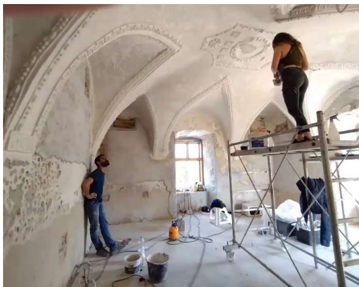
A fitafalvi Ugron kastély kápolnája munka közben
