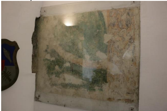
Vörös toronyban lévő fogadótér belső fala
