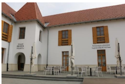
Borsi, Rákóczi-kastély, újjáépített szálloda-étterem szárny
