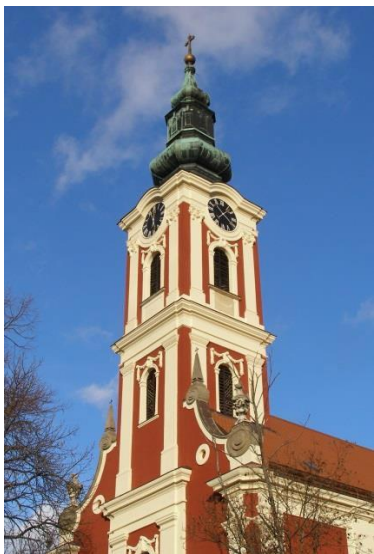
Szentendre, Belgrád székesegyház – külső és tetőszerkezet felújítása, héjazatcsere
