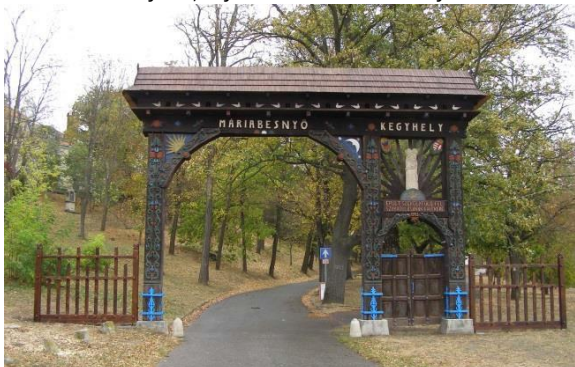
Gödöllő-Máriabesnyő – Székelykapu szerkezeti megerősítése, heylreállítása, zsindefedés cseréje, díszítések restaurálása
