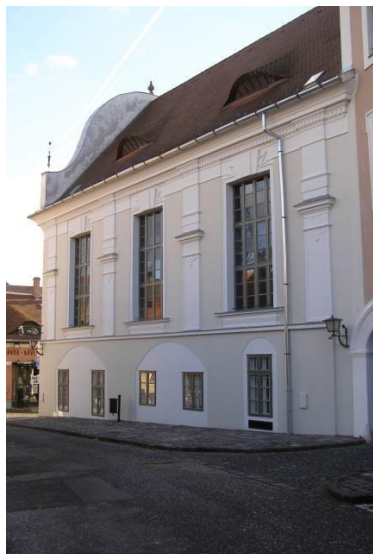
Szentendre, Városháza – ÉK-i homlokzat felújítása
