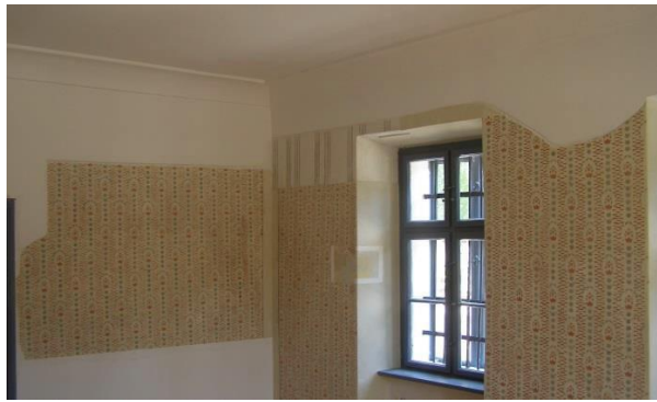
Dabas, Bajcsy-Zs. u.14 – Gombay-Dinnyés-kúria megmaradt díszítőfestés konzerválása, értelmező kiegészítése
