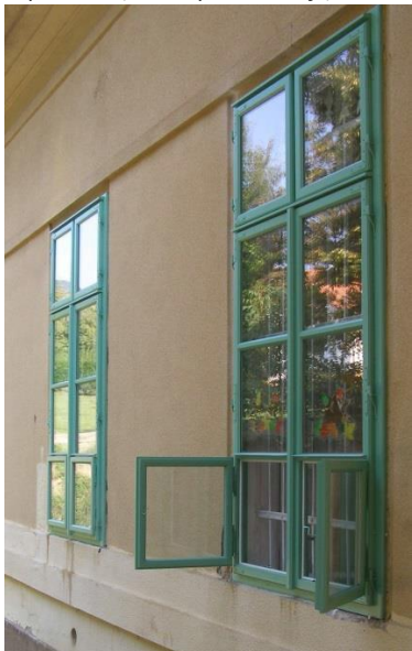
Pilisszántó – Jurkovics-Baross kúria külső ablakok cseréje, energetikai felújítása
