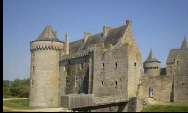
1990 TOITURE ARDOISES D. Lefèvre acmh SLATE ROOF
