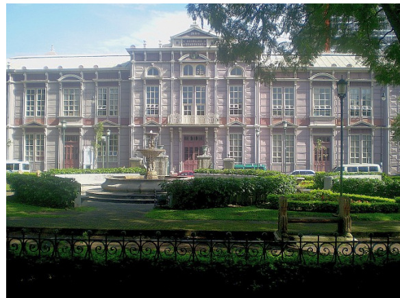
A főváros központjában lévő iskola vasszerkezettel, vaslemez borítással épült
