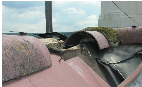
Hiányzó kúpcserépeknek "köszönhetően" folyamatos a beázás;Ajka, Tóskoberénd; Katolikus templom
