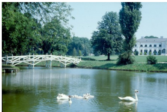
A helyreállított seregélyesi kastély és a park (1985)
