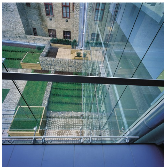
Magház Társasház, Budapest, 2002. Dévényi Tamás
