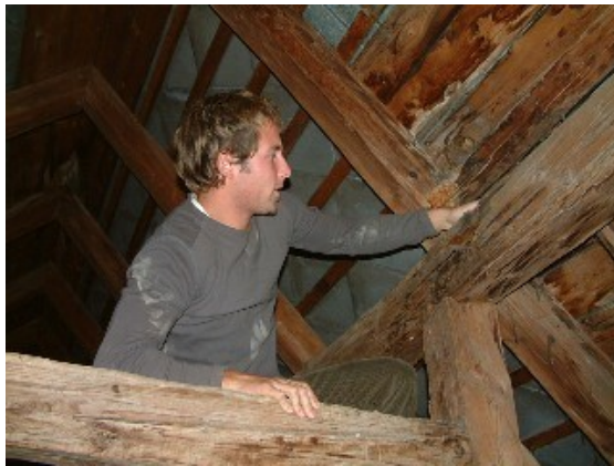
Fedélszerkezet vizsgálat közben; - Veszprém, Szent Margit templom
