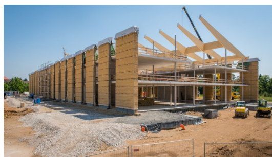
1-2. ábra Martin Rauch (Lehm Ton Erde) látszó vert falazat üzemi előregyártása és helyszíni összeszerelése (forrás: https://www.lehmtonerde.at/en/ )
