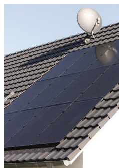
15. ábra Creaton tetősíkba integrálható napelem rendszerek a.) Cretaon rendszere [11], b.) Tondach Wevolt X-Tile rendszere [1]
