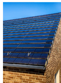
15. ábra Creaton tetősíkba integrálható napelem rendszerek a.) Cretaon rendszere [11], b.) Tondach Wevolt X-Tile rendszere [1]
