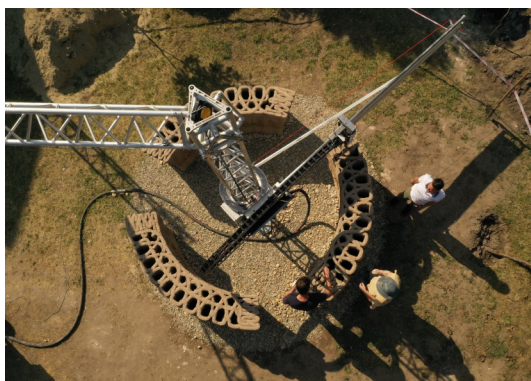
3-4. ábra A WASP Crane nyomtatóval készült első vályogépület (balra) és az Ökodome csoport saját fejlesztésű kupaépülete nyomtatás közben (jobbra) (forrás: Bihari Ádám)
