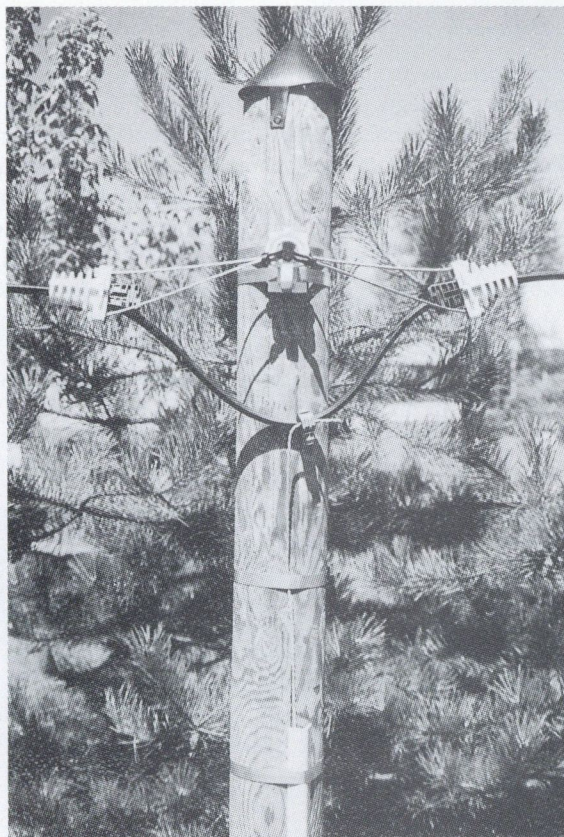
1. ábra. Kábelkötés MALICO ÖKV-vel. (Kábel földelés CMT 113 földelő csatlakozóval, a földelt kábelt acélheveder rögzíti az oszlophoz.)
