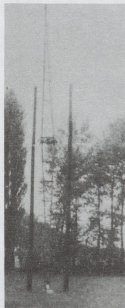
2. fénykép. A lineárisan kicsinyített modell antenna kialakítása
