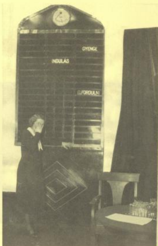
Beöthy Baba bemondó (a háttal szerint) (1931-32 körül). Az 1928-ban épült nagy stúdió utasító tabulatúrája. Ennek segítségével irányították a szereplőket adás közben. A feliratok mögötti lámpák bekapcsolása a megfigyelő helyiségből történt.
