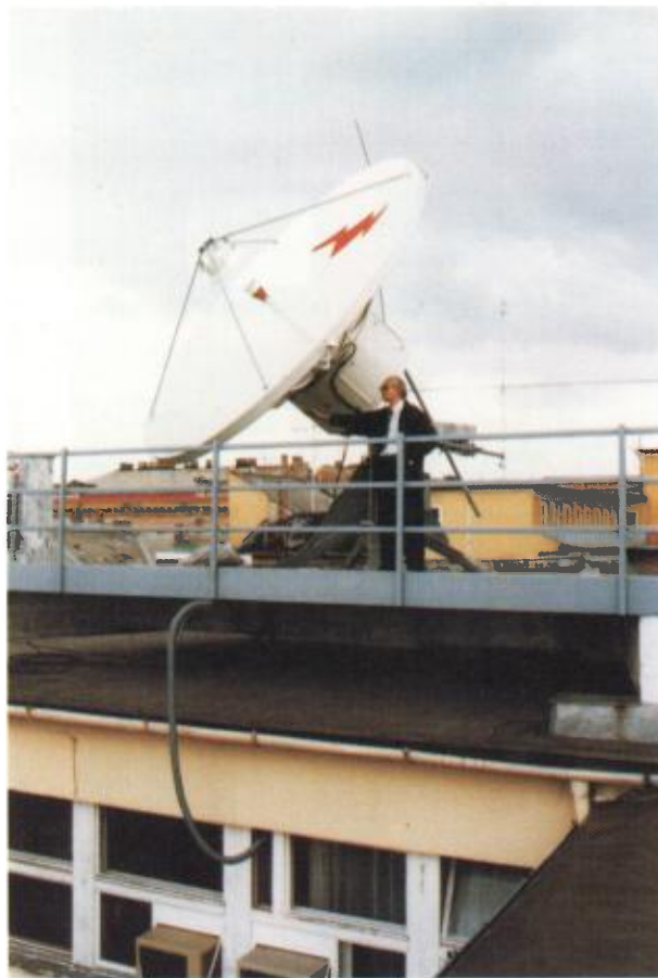
Az „ANDREW”-gyártmányú, 3,8M. átmérőjű antenna a stúdióépület tetején. Ferenczi Imre műholdas szakmérnökkel. 1996.
