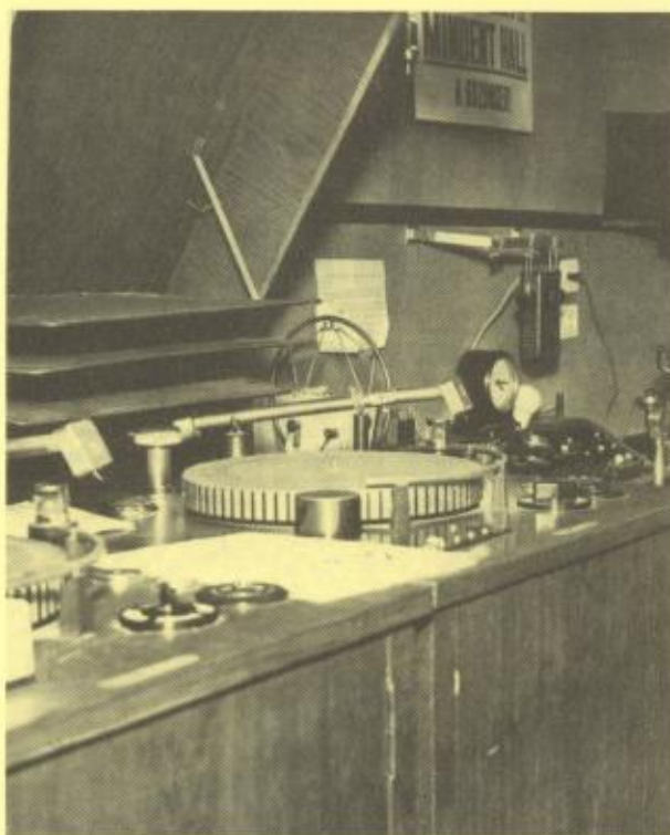
A VII. lemezjátszó-bemondó stúdió részlete. A lemezjátszó maga fából készült szekrényben van elhelyezve álló kezeléshez. A padlómotor rugalmas tengelykapcsolóval nehéz tányért hajt. A tányér peremén stroboszkóp beosztás 78/p fordulátú lemezek lejátszásához. Indító kamrás kapcsoló. A hosszú hangszedő karon Telefunken lejátszófej cserélhető acél tűvel. A korong mögött látható a lemez központosítását rögzítő súly. Ezek a lemezjátszók 1949-50-ig voltak üzemben.
