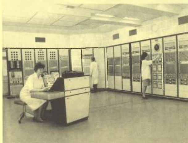
A WSW gyártmányú központi kapcsolóterem. (Épült 1964-ben.) A vezérlőasztalnál Szekeres Sarolta, a végtelenített szalagos szünetjelgépnél (előlap levéve) Chomát Vilmos csoportvezető.
