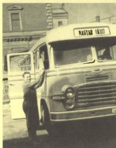
Ikarus 31 közvetítő kocsis. Épült 1957-ben, Lorenz V45a 4 csatornás keverő-erősítővel (NDK ajándék), Philips 10039/02 típusú, 76,2 cm/s szalagsebességű magnetofonokkal, a saját áramellátását biztosító 1,2 kVA-es motorgenerátorral és 6 db. 12V, 200 amperórás akkumulátorral. 1961-ben átépítésre került. A képek 1961-62-ben készültek. Az alsó képen Kalmár Sándor kábeles.
