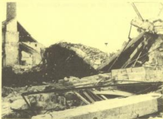
▲ A lakihegyi rádióállomás 1944. december 6-án felrobbantott adóépületének romjai, a romok alatt a 120 kW-os Standard adó.
