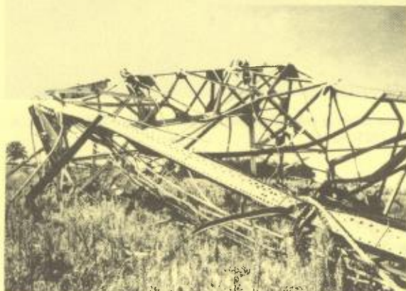
▼ A lakihegyi 314 m-es „szivar” antennatorony lerobbantott középső része a földön. 1945.
