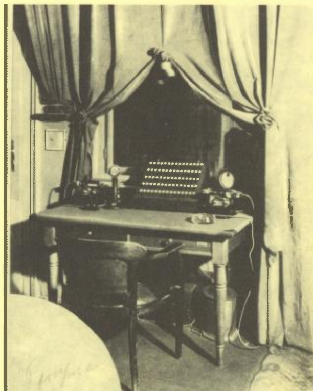
Az 1928-ban épült Sándor utcai stúdióban az 1. sz. nagystúdió megfigyelő helyisége. Középen a transzparens utasító pultja 75 kapcsolóval, bal oldalt utasító mikrofon, jobbra kivezérlés-mérő műszer, telefonok, megfigyelő hangszóró, erősítő az asztal alatt. Függöny csillapítás.
