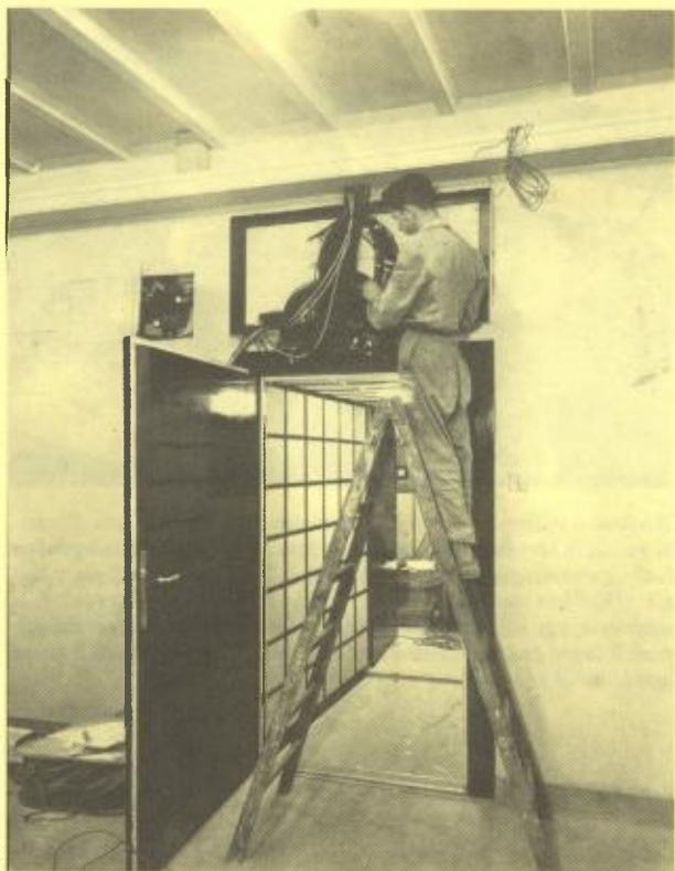
A Szentkirályi utcai stúdióépület földszintjén a XXI. sz. (ma 11. sz.) felolvasó stúdió bejárata. Csatlakozó kábelek bekötése előtt a párkánycsatornából érkező kábelek azonosítása. 1950.
