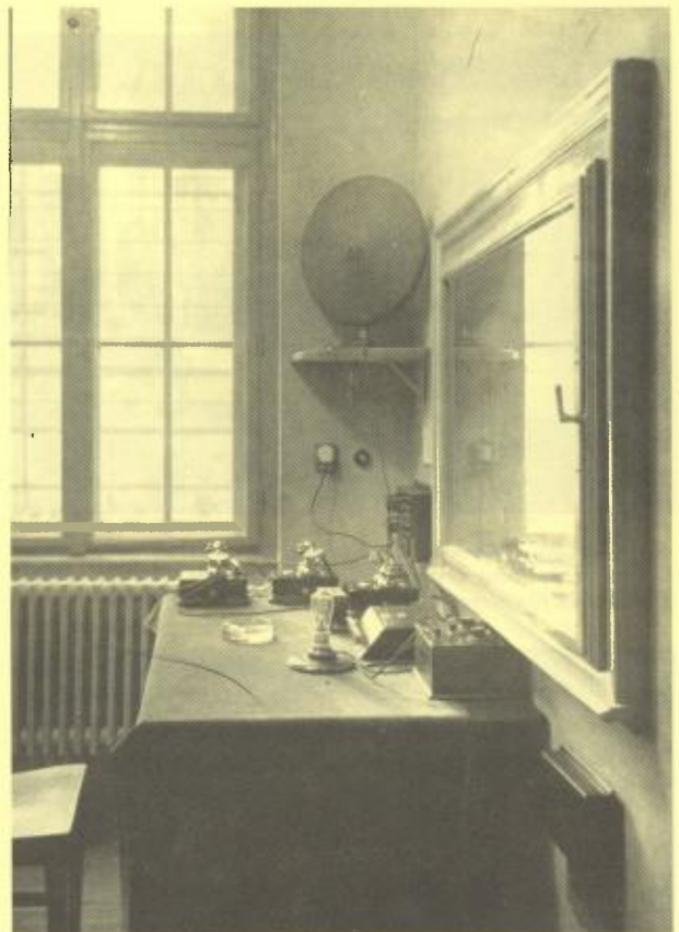
A IX. stúdió megfigyelő-rendező helyisége. Épült 1932-35 között a Sándor utcai stúdió első bővítésekor, az épület ÉNy-i sarkán, a földszinten. (Korábban itt volt a próbaterem.) Az asztalon közepén a transzparens utasító tábla kapcsoló doboza (választó kapcsoló, hangerő-szabályozó), balra a telefonok, a sarokban a polcon a megfigyelő hangszóró.
