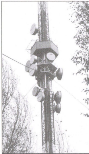
8. ábra Szentes TV-torony Antenna-elrendezés 2000. november
