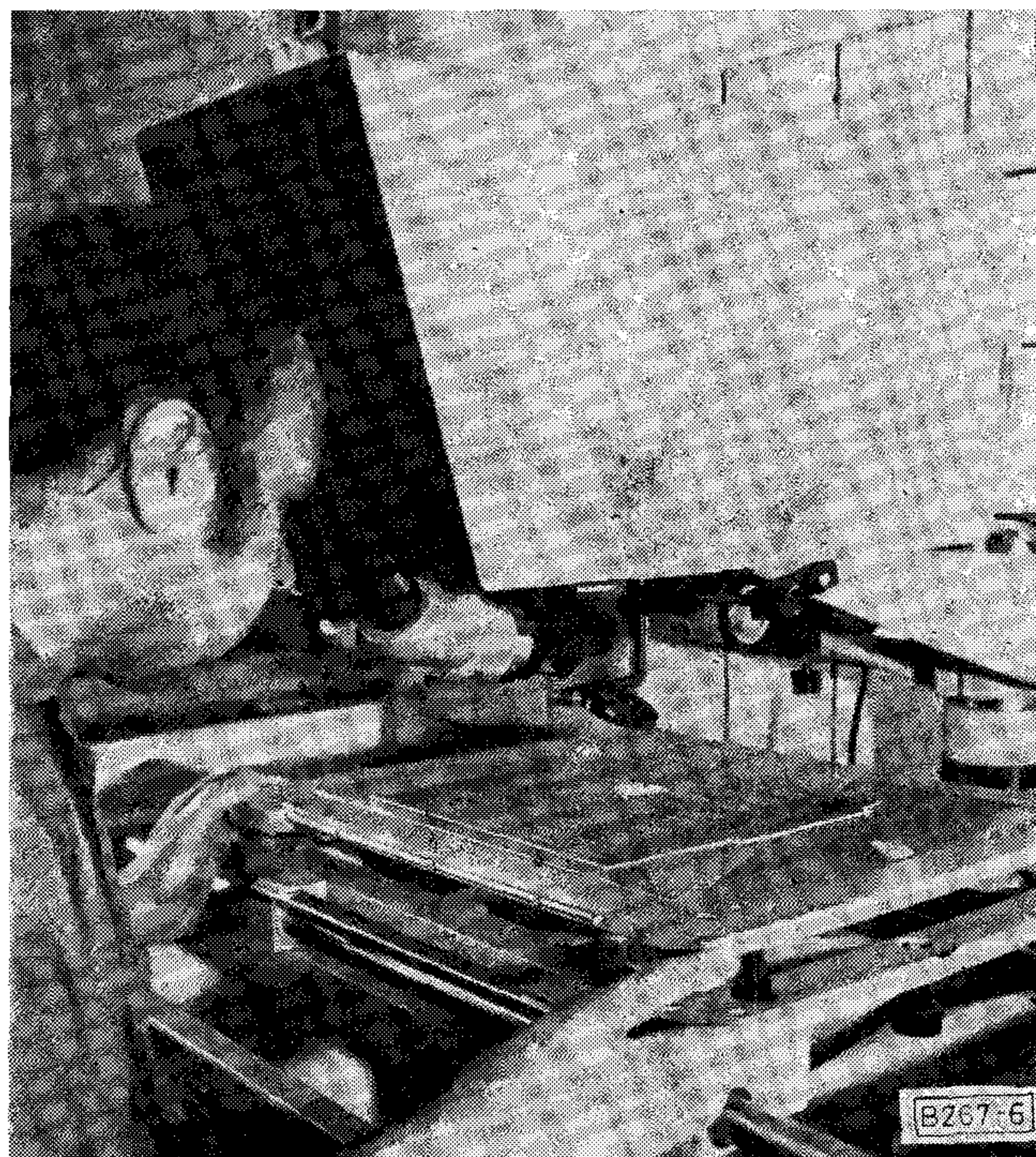
6. ábra. Furatfémezés ellenőrzése mikroszkóppal
