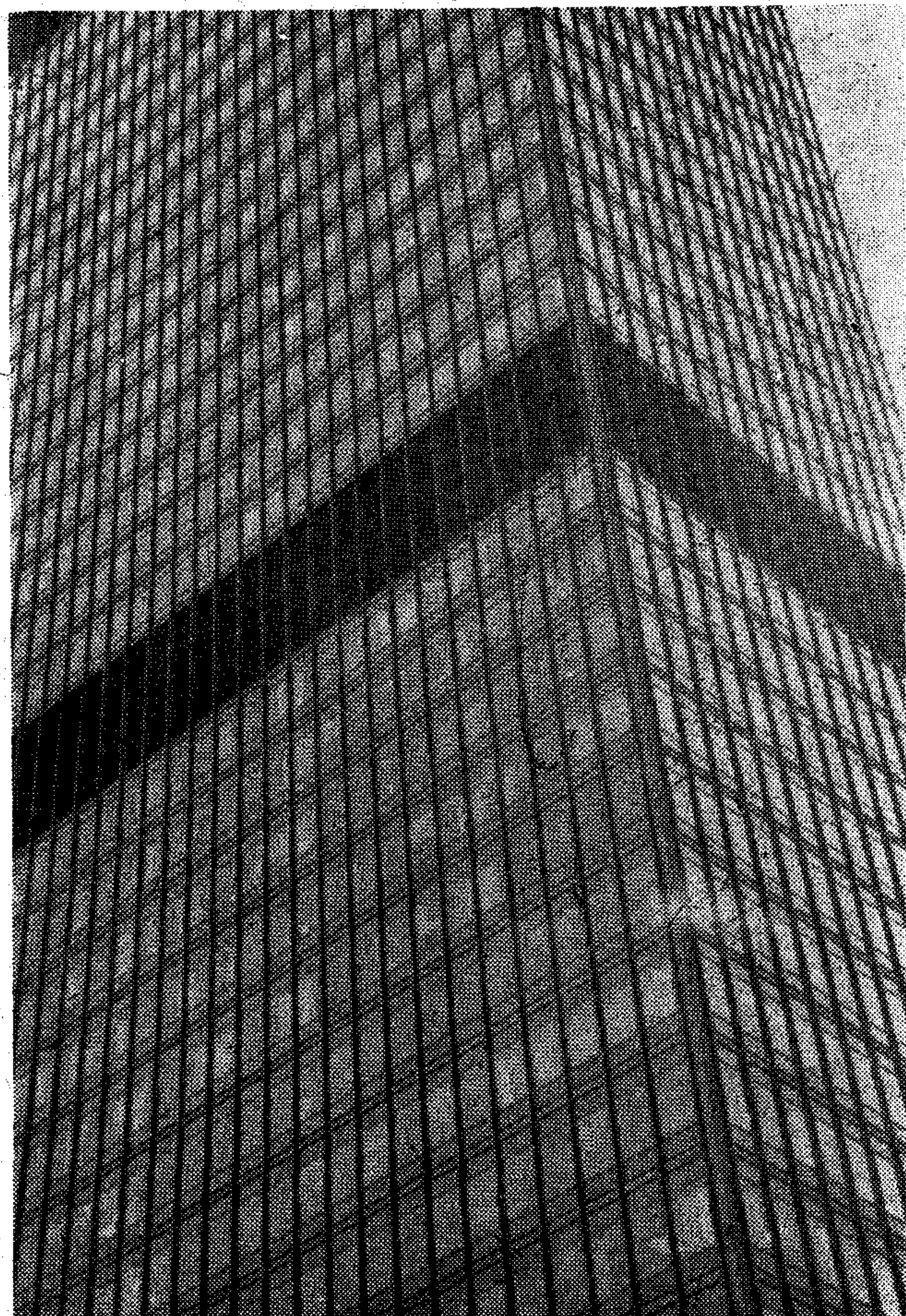
1. ábra. Az acélvázaz épület teljes árnyékolást jelent. Itt nélkülözhetetlen a kábeles televízió
