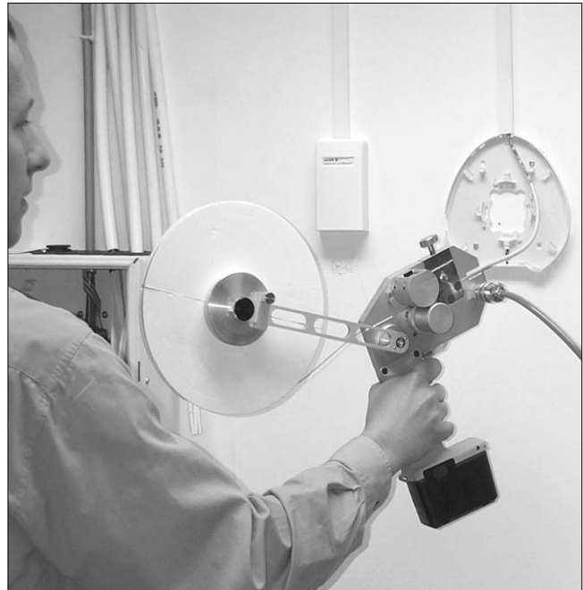
4. ábra Ribbonet szálak befűvése
