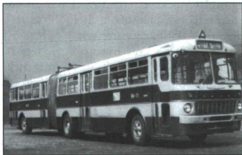
20. ábra „IKARUS 180” TÍPUSÚ, ÖNHORDÓ CSUKLÓS AUTÓBUSZ RÁBA-MAN MOTORRAL FORGALOMBA ÁLLÍTVÁ 1964-BEN
