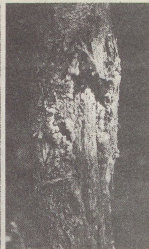
Baloldalt: Út menti lucos károsodása sózás következtében
