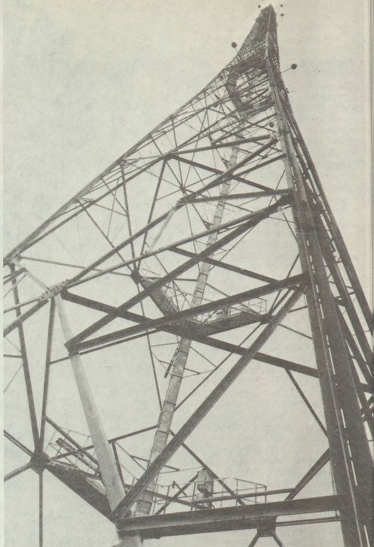
Elkészült az üzem területén a 120 méter magas meteorológiai megfigyelőállomás
