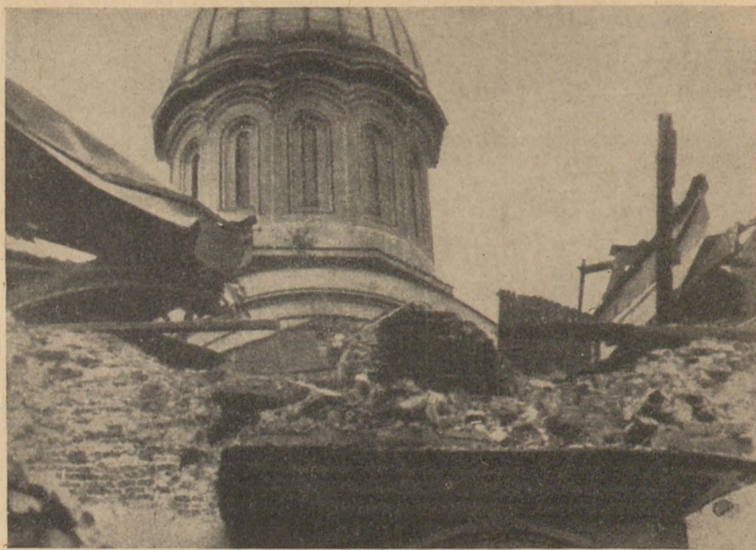
A bukaresti Popa-Tatu-templom ne- héz kupolaszerke- zete szétnyomta a falakat
