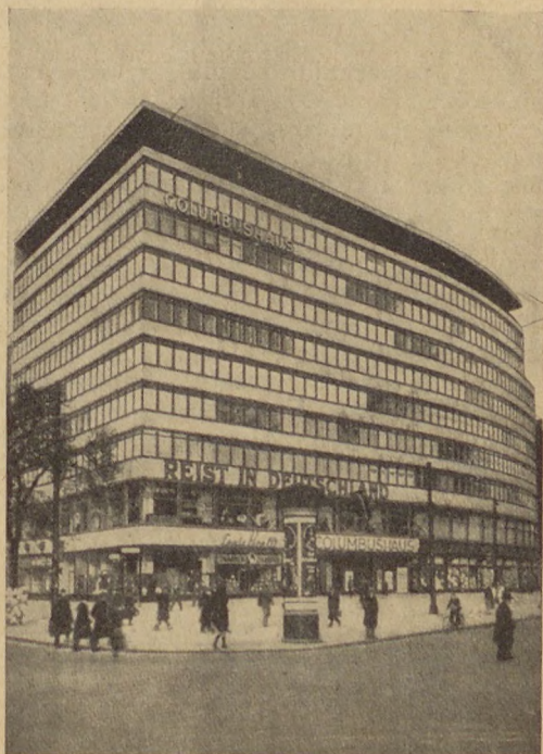
Berlini üzletház üveghomlokzata
