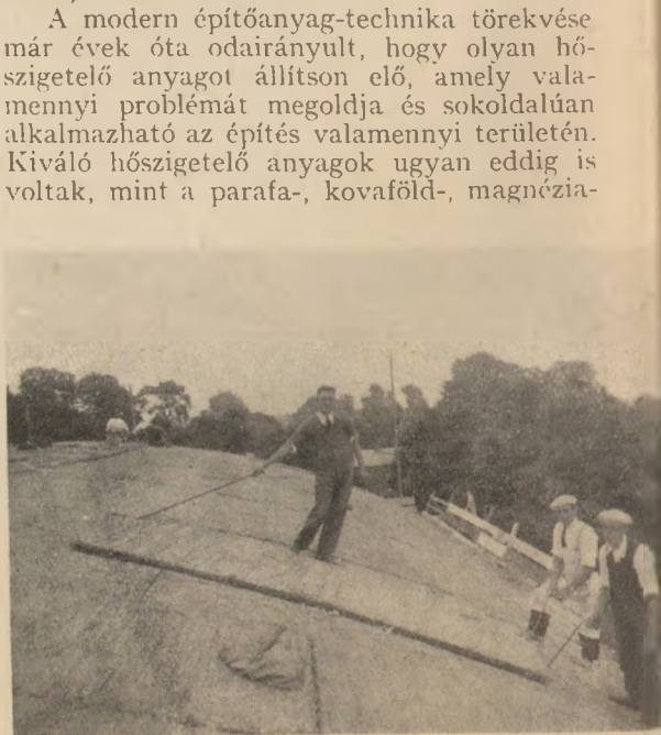
Az A. R. P. filmstudió órlási boltívénak hőszigetelése szalmalemezekkel, Ealing, London mellett
