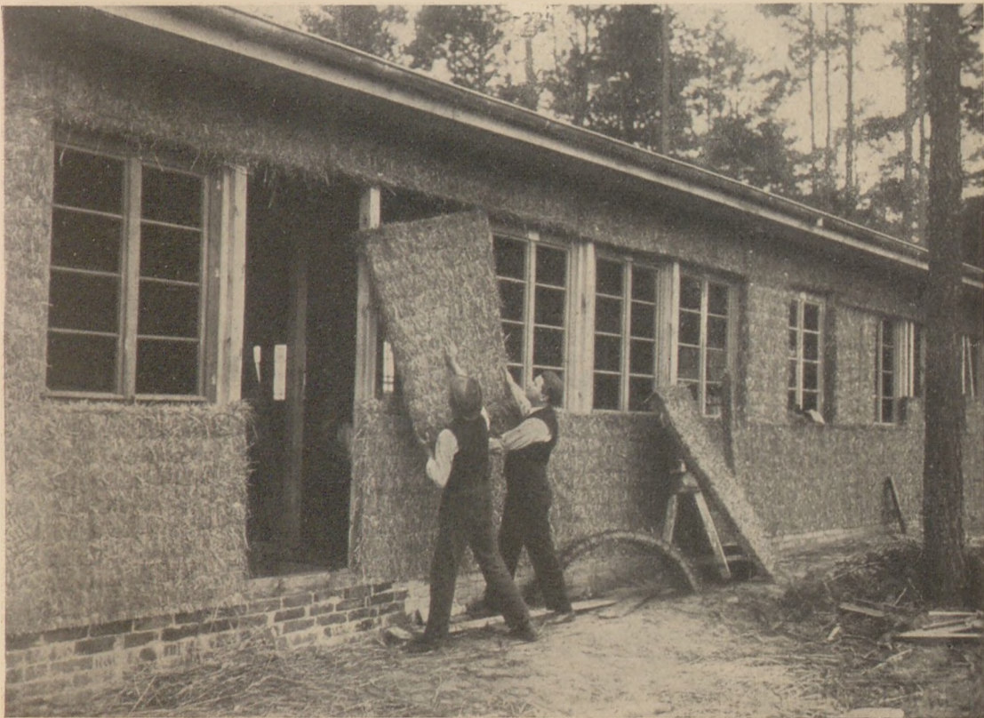
Külső falépités szalmalemezekkel. A Berlin földalatti vasút irodaépülete
