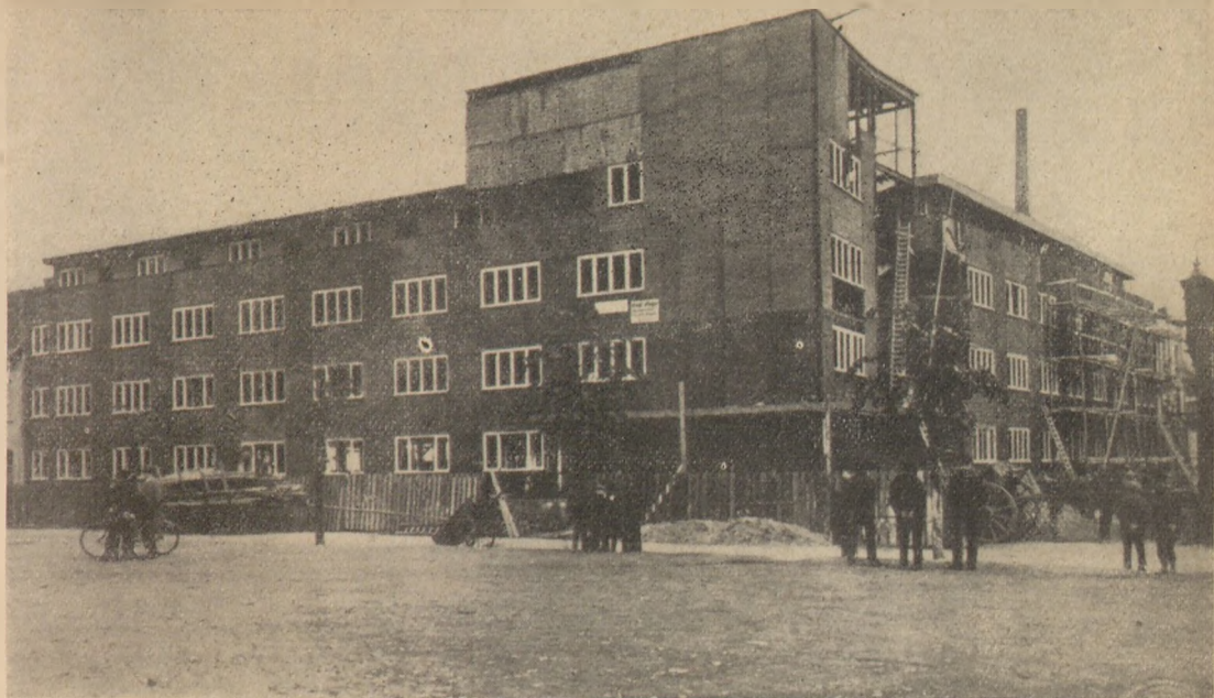
Acélvázás épület hőszigetelése szalmalemez zel
