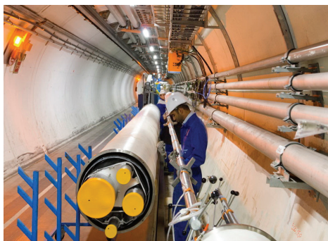
A hűtő-csővezeték beszerelése. A vezetékben szuperfolyékony hélium áramlik Ez a rendszer biztosítja a szupravezető mágnesek hűtését.
