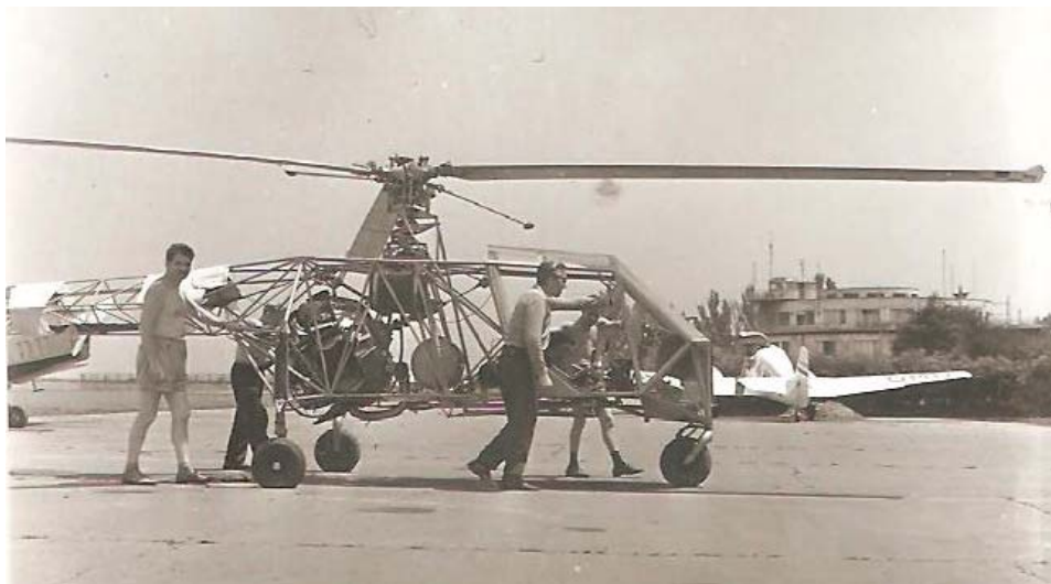
17. számú ábra. Az SOH-1 motorpróbái a Budaörsi Repülőtéren zajlottak. A képen megfigyelhető a 30°-os szögben beépített csillagmotor, mellette a tüzelőanyag-tartály és fölöttük a reduktor. 83 A képen Hatházi Dániel (hátról) és Kaszás Imre (előlről) felismerhető
