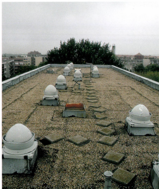
94. Gyöngykavicsos lapos tető változatosabb alapszínű felszíne. A szellőzőkupolák mellett jellegzetesek a beton járólapok is. – Flat roof with sbsingle surface
