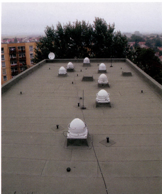
93. Kátrányos lapos tető teljesen kopár, egyhangú felszíne. A fehér kupolák alatt helyezkednek el a szellőzőkürtők ventilátorai. – Tarred flat roof
