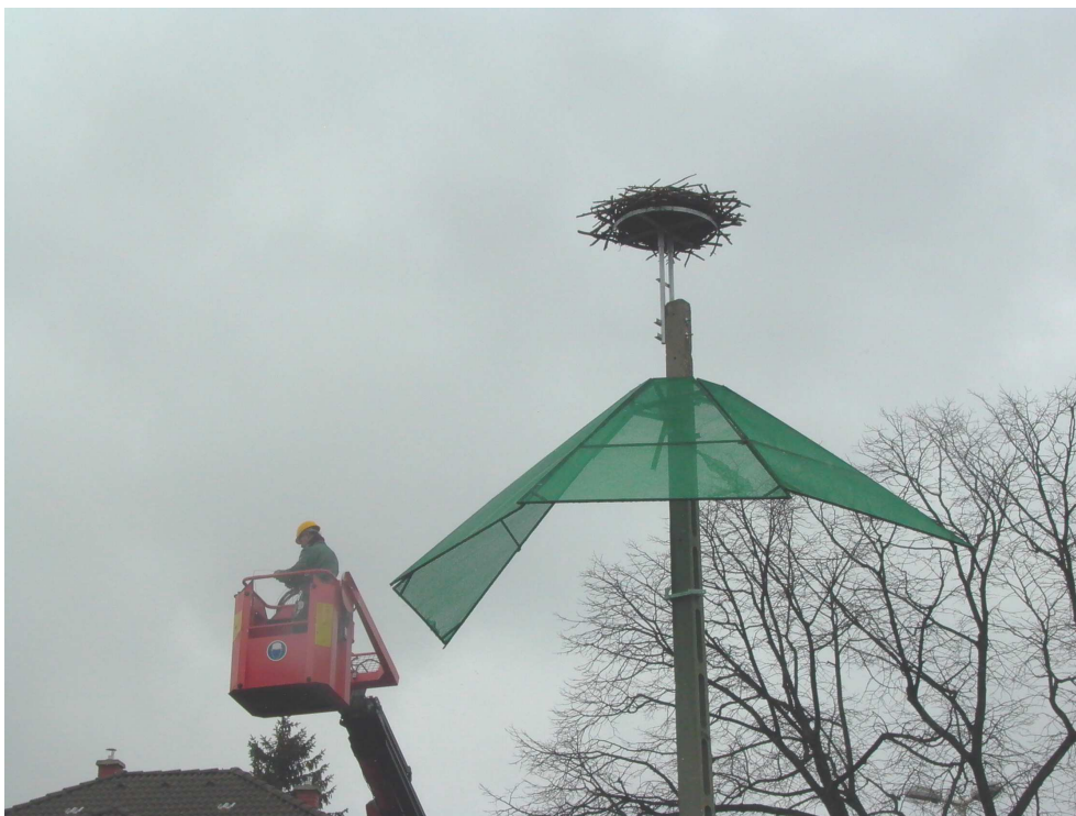
Bükön a parkoló és a gyalogjáró közelében lévő új fészek alá Barbácsy Zoltán és Gruber Ágnes épített „gólyapelenkát”. Fém szerkezeten duplán kifeszített Raschel hálóból áll az alkatosság, csaknem 20 m 2 felületen (fotó: Gyurácz J.)
