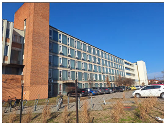
2. ábra. A Műszaki Kar keleti tájolású szárnya
