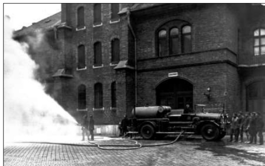
3. ábra. Bemutató a fekvőhengeres szárazoltóval a Kun utcai laktanyában [4]
