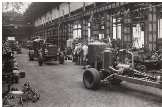
6. ábra. Állótartályos szárazoltó szerelése a Mávag-ban 1939–1940 között [11]
