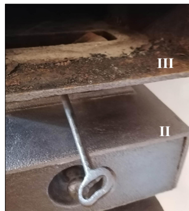
2. ábra. A füstgázjelző, kurtító zárt állapota
