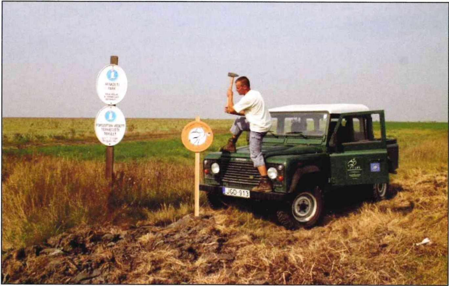
7. kép: Tűzokvédelmi terület kijelölése a Kiskunságban (fotó: Lóránt Miklós) Picture 7: Installing a sign of the project area in the Kiskunság (Photo: Loránt Miklós)
