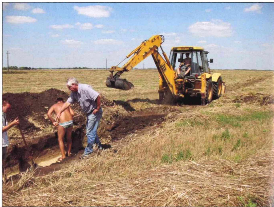
9-11. kép: Légkábel földbe helyezése a Borsodi-Mezőségben (fotó: Dudás György) Picture 9-11: Burying the electric power lines in the ground in the Borsodi-Mezőség (Photo: Dudás György)
