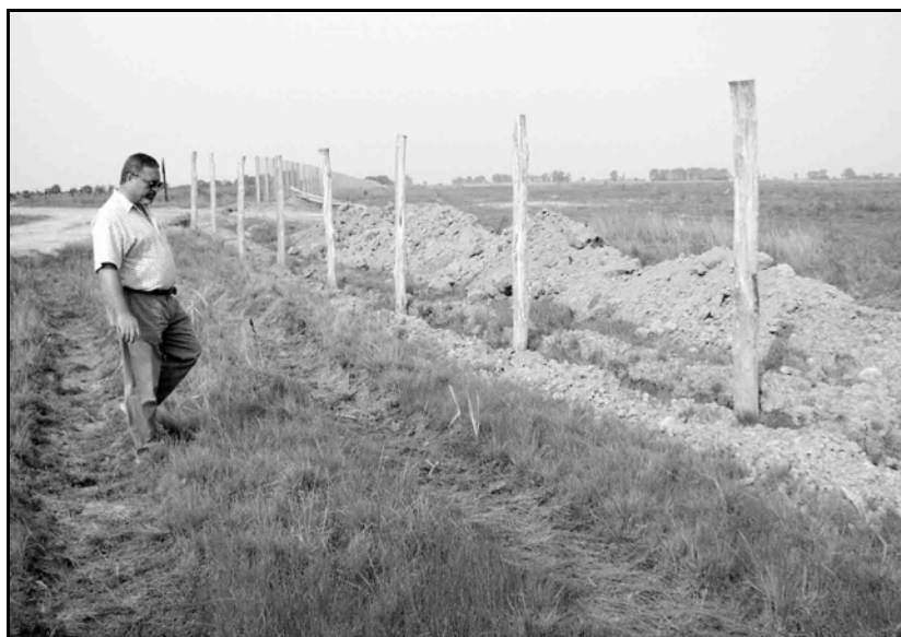
12. kép: A kerítés nyomvonalának kiásása és oszlopállítás 2002-ben (FOTÓ: SZÉLL, A.)
