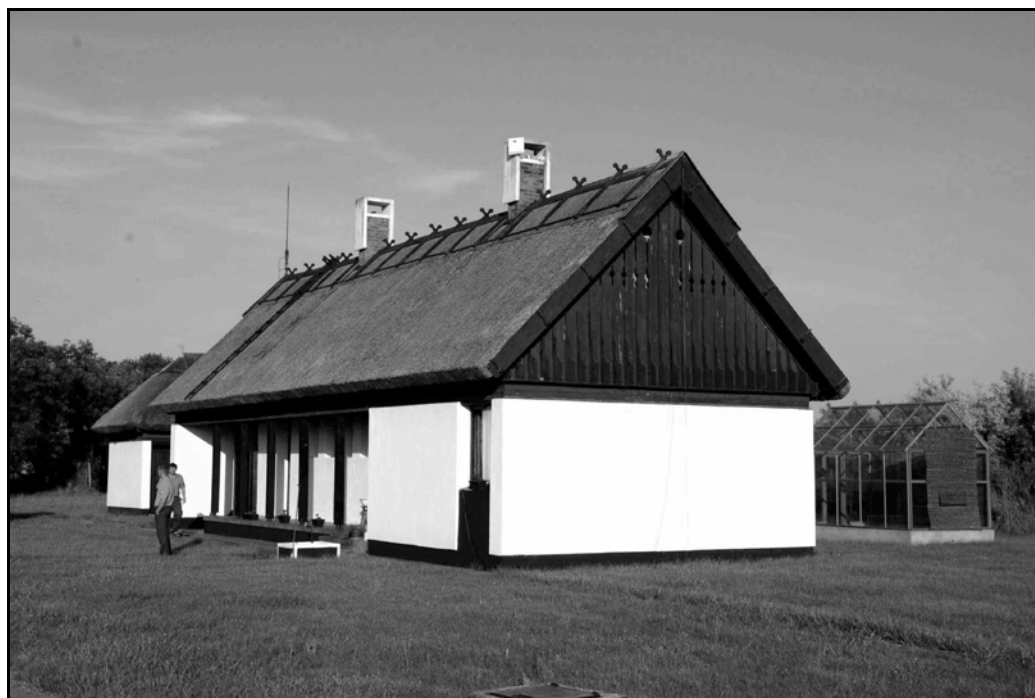
1. kép: A Tűzokvédelmi Állomás technológiai épülete (FOTÓ: TIRJÁK, L.)
