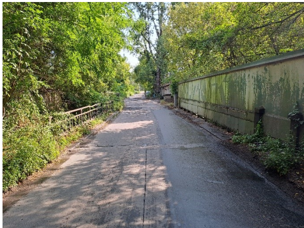
3-4. ábra: A híd kocsipálya nézete északi irányba és az öböl felőli hídkorlát, a ráépített tömör kerítéssel (szerző felvétele).
