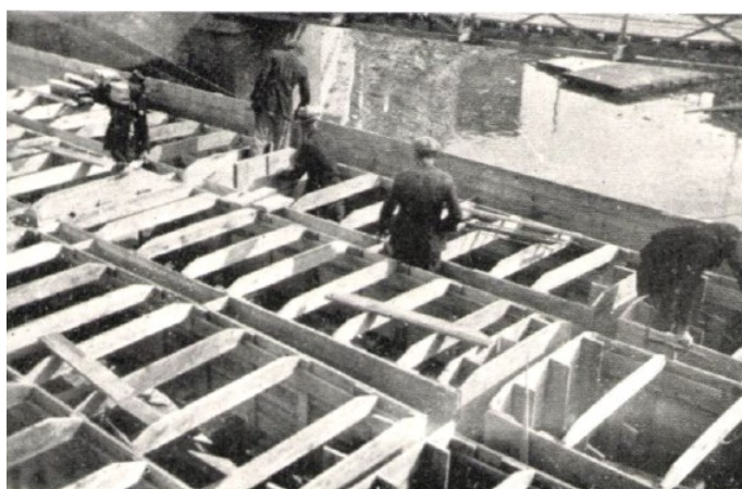
16. ábra: Az 1932-ben épített felszerkezet zsaluzata [8].
