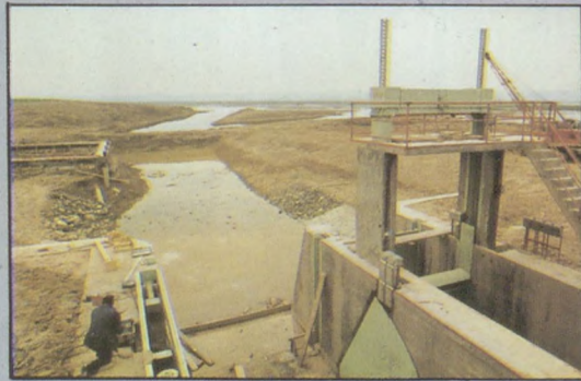
Építés közben . . . A Zala torkolatvidék kialakítása Elkészült a vízszint szabályozását szolgáló zsilip is
