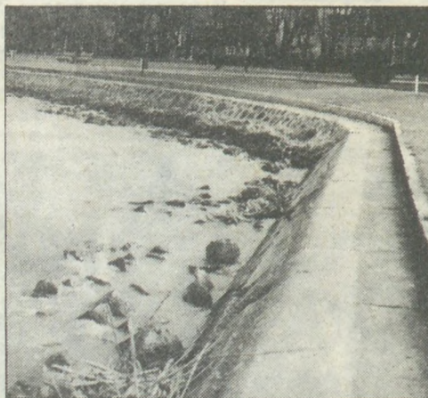
A meredek rézsűjű kiépített part az öntisztulási folyamatot megakadályozza, és a szerves törmelék a tó vizében marad
