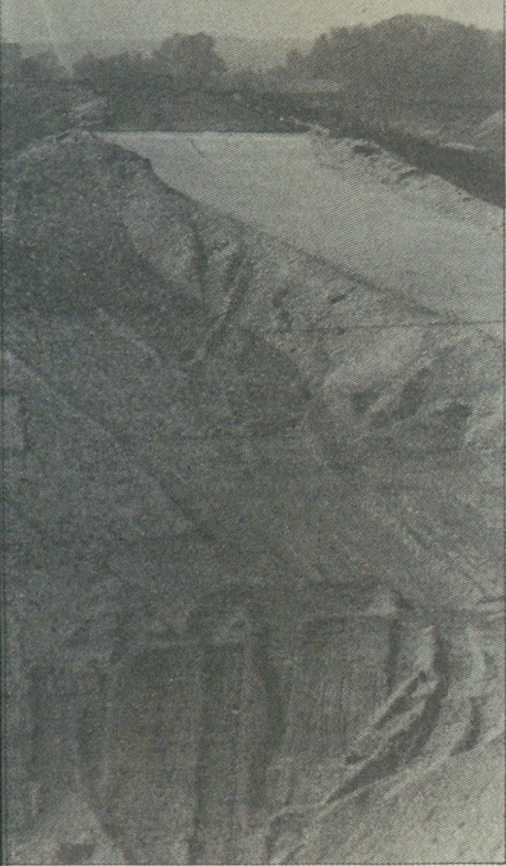
Tejfalu (Mliečno) határában a tározótöltést geotextiliával takarják
