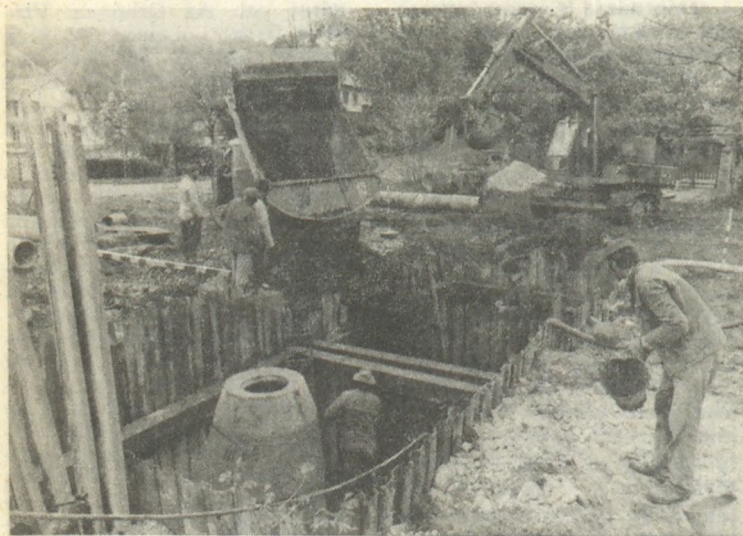
A két évvel ezelőtti járvány miatt a káptalanfüredi üttörőtábor kapui tavaly zárva maradtak. Most a Dunántúli Vízügyi Építő Vállalat végre megkezdte a szennyvízcsatorna építését
