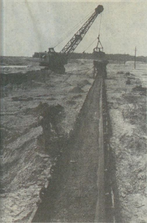
Parti, lánctalpas, dobókanalas gépekkel csak rossz hatásokkal termelhető ki a kavics
