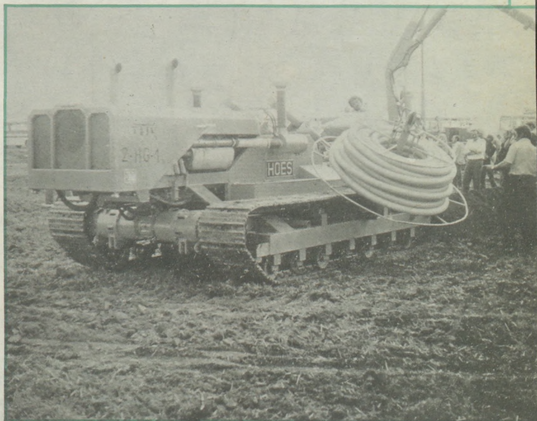
A korszerű talajesőfektetés modern gépi berendezéssel
